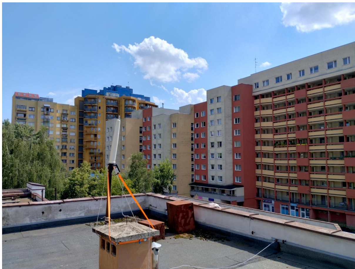
Rys. 3 Miejsce montażu SMS PEM – Szkoła Podstawowa nr 118
