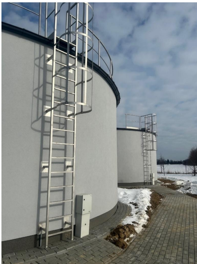
Fot. Zbiorniki wodociągu Krasne (źródło: Zakład Usług Komunalnych w Krasnem)
