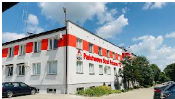
Budynek Komendy Powiatowej Państwowej Straży Pożarnej w Ciechanowie
