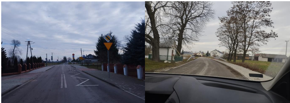
Zdj. 1 skrzyżowanie na DG nr112301E w m. Wiewiórów Zdj. 2 zakres organizacji ruchu na DP nr 3918E
