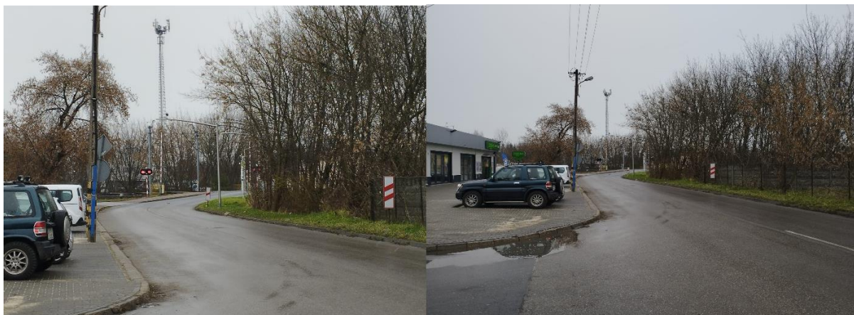
Zdj. 7-8 oznakowanie skrzyżowania kolejowo-drogowego na DP nr 3952E ul. Piłsudskiego w Radomsku.
