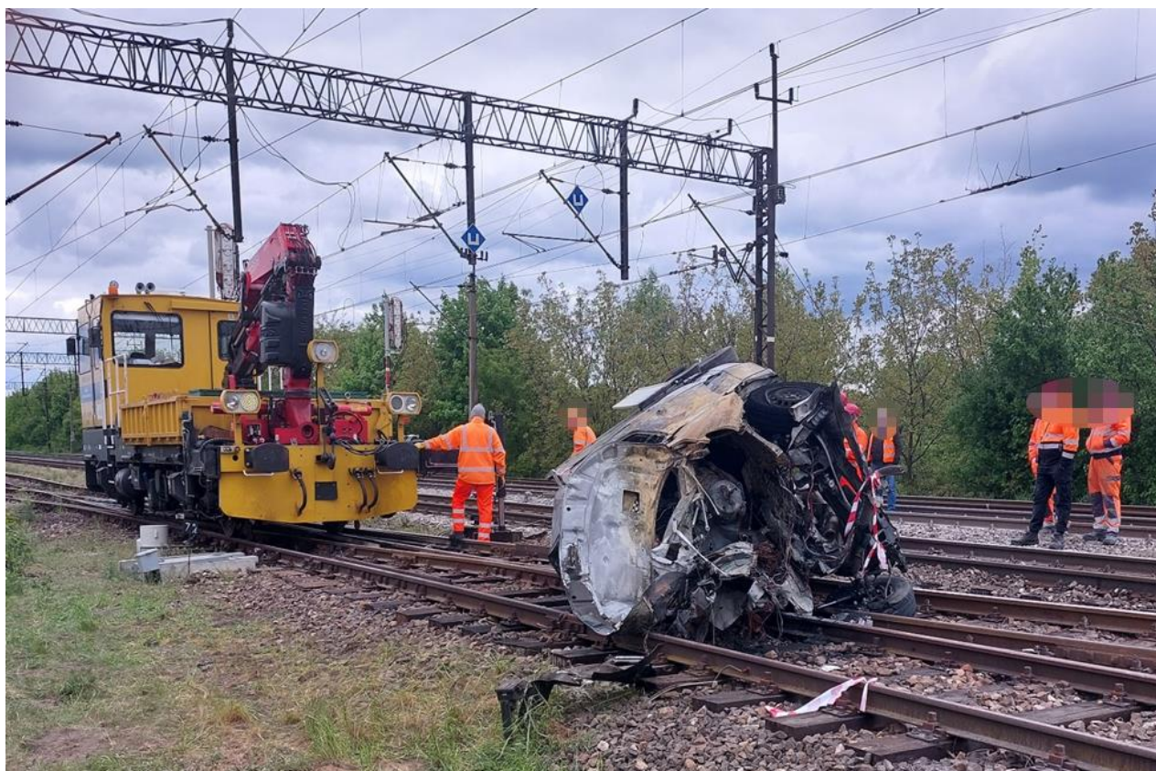
Zdjęcie 11 – Usuwanie skutków poważnego wypadku (źródło: materiał własny PKBWK)
