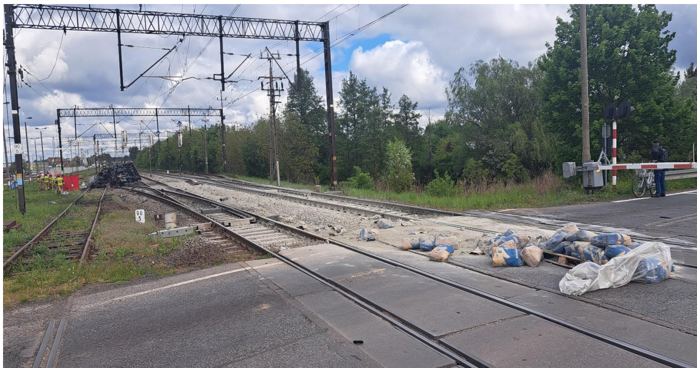
Zdjęcie 3 - Skutki zdarzenia (źródło: PKP PLK S.A.)
