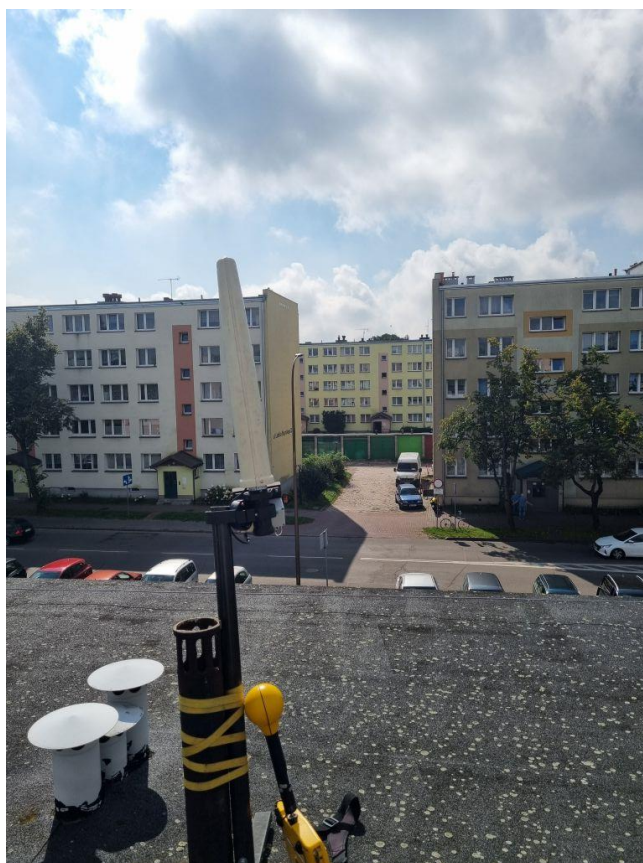
Rys. 4 Miejsce montażu SMS PEM – Przychodnia Lekarska w Suwałkach – widok na SBTk
