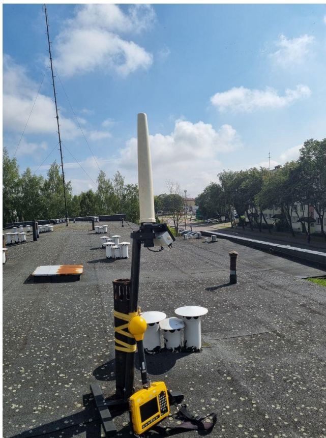
Rys. 3 Miejsce montażu SMS PEM – Przychodnia Lekarska w Suwałkach – widok na SBTk
