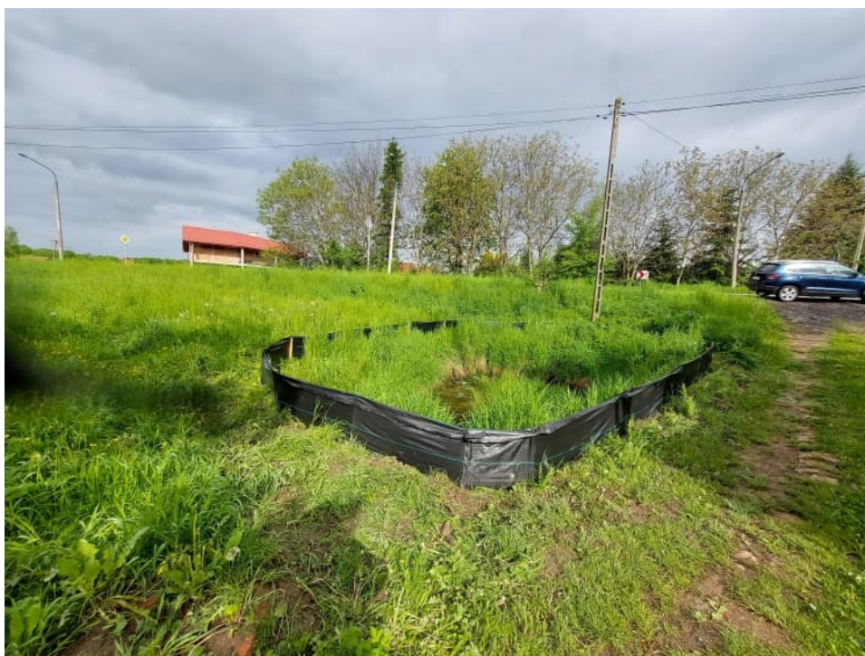
Foto. 23. Zabezpieczenie miejsca rozrodu chronionych gatunków płazów – droga dojazdowa do placu składowego na odcinku 1.4, stan w drugiej dekadzie maja 2021 r. (widok w górę rzeki).
