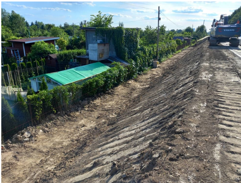
Foto. 41. Wyrównywanie skarp wału przeciwpowodziowego – lewy wał Wisły na odcinku 1.1, stan w drugiej dekadzie czerwca 2022 r. (widok w górę rzeki).
