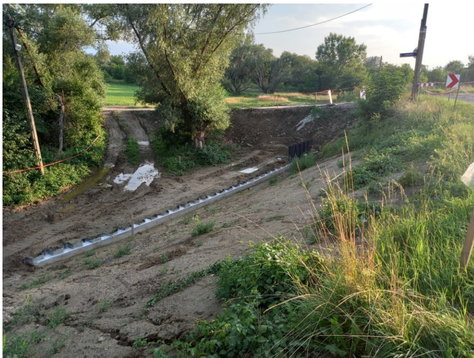
Foto. 34. Wykonywanie oczepu na ścianie szczelnej u podstawy wału – lewy wał Wisły na odcinku 1.1, stan w trzeciej dekadzie lipca 2022 r. (widok w górę rzeki).
