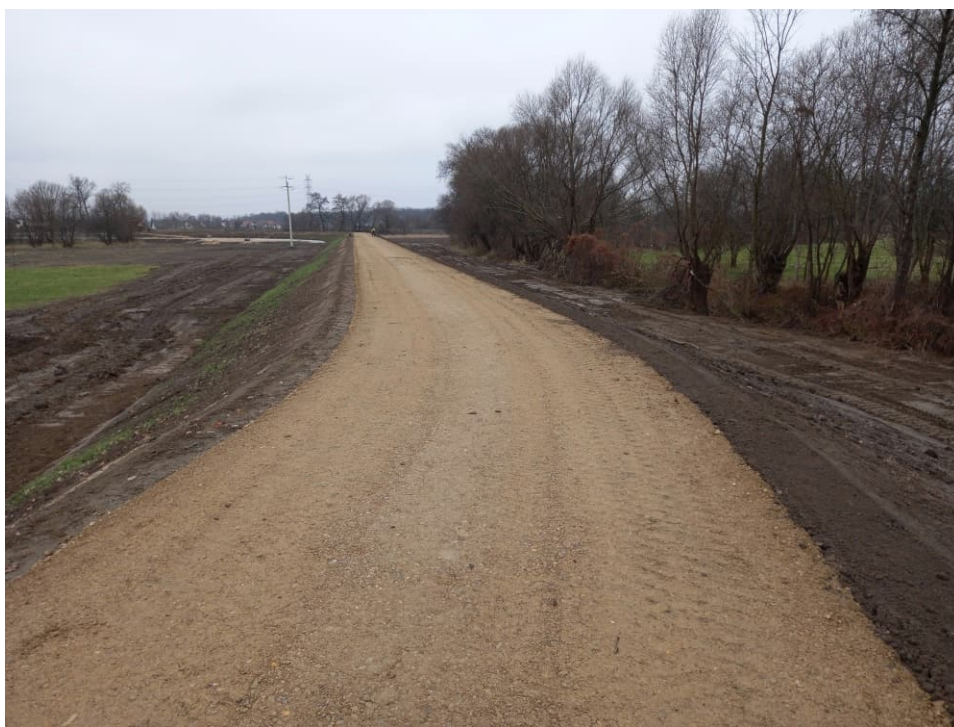
Foto. 47. Budowa drogi na koronie wału przeciwpowodziowego – lewy wał Dłubni na odcinku 1.6, stan w trzeciej dekadzie listopada 2022 r. (widok w dół rzeki).
