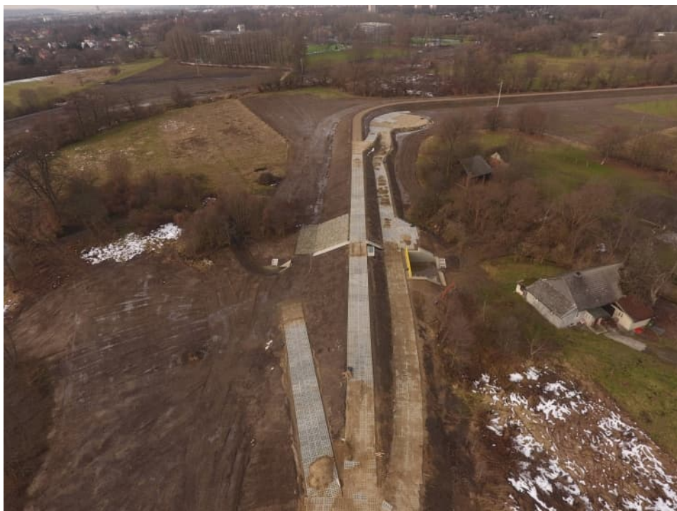
Foto. 56. Stan terenu budowy w ostatnim kwartale okresu realizacji robót – nowo wybudowany lewy wał Dłubni na odcinku 1.6 , stan w trzeciej dekadzie grudnia 2022 r. (widok w górę rzeki).
