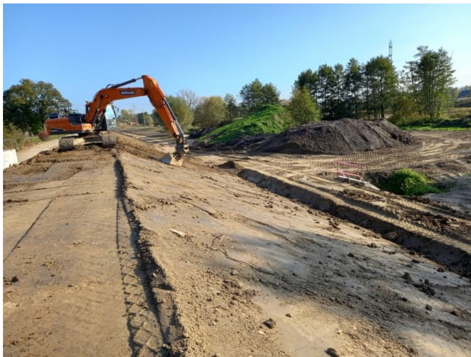
Foto. 42. Wyrównywanie skarp wału przeciwpowodziowego – lewy wał Dłubni na odcinku 1.6, stan w drugiej dekadzie października 2022 r. (widok w dół rzeki).
