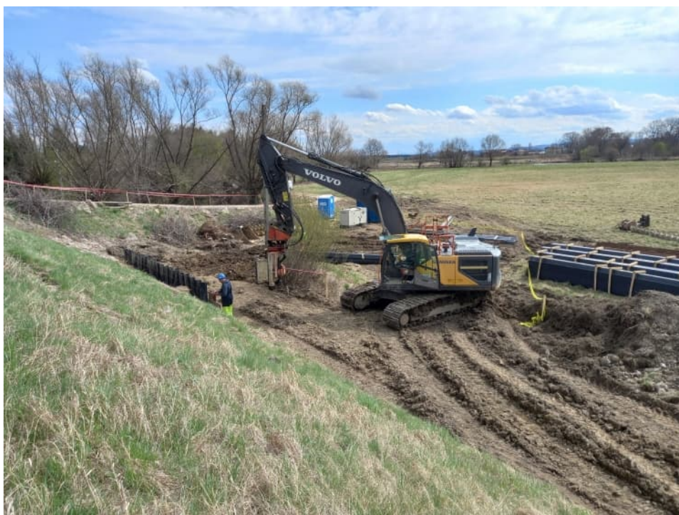
Foto. 33. Wykonywanie ścianki szczelnej u podstawy wału – lewy wał Wisły na odcinku 1.1, stan w pierwszej dekadzie kwietnia 2022 r. (widok w dół rzeki).
