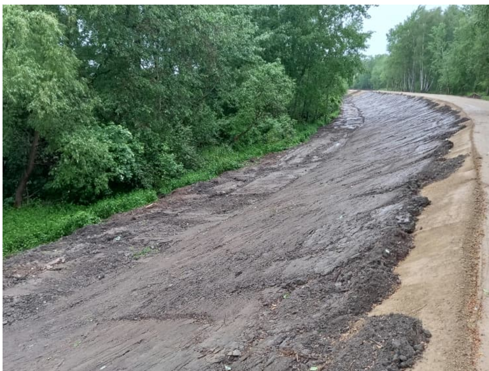
Foto. 45. Humusowanie skarp wału przeciwpowodziowego – lewy wał Wisły na odcinku 1.3, stan w trzeciej dekadzie maja 2022 r. (widok w górę rzeki).
