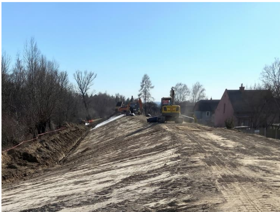
Foto. 44. Układanie bentomaty na skarpie wału przeciwpowodziowego – prawy wał Dłubni na odcinku 1.4, stan w trzeciej dekadzie marca 2021 r. (widok w dół rzeki).
