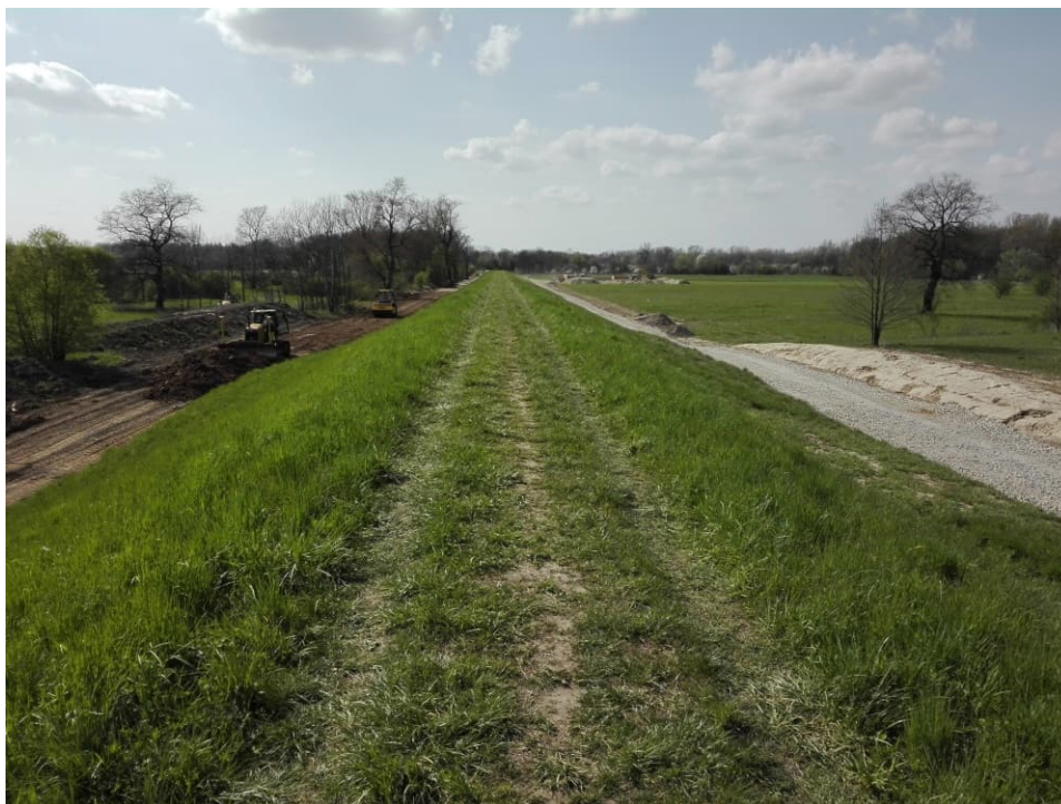
Foto. 28. Zdejmowanie warstwy humusu – lewy wał Wisły na odcinku 2, stan w trzeciej dekadzie lipca 2021 r. (widok w górę rzeki).
