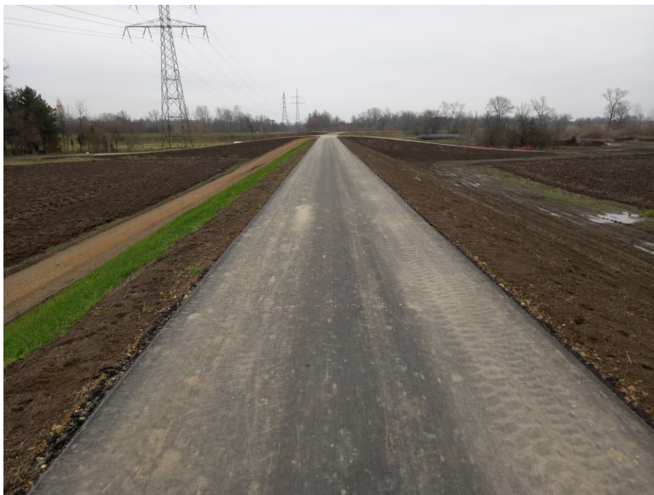
Foto. 48. Budowa drogi na koronie wału przeciwpowodziowego – lewy wał Wisły na odcinku 2, stan w trzeciej dekadzie listopada 2022 r. (widok w dół rzeki).
