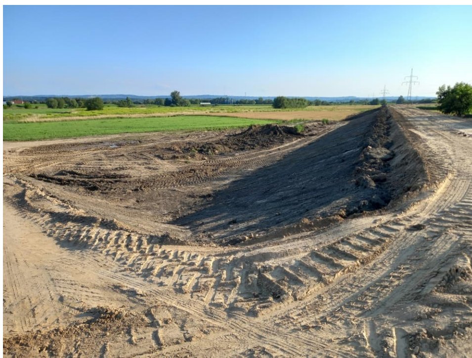
Foto. 46. Humusowanie skarp wału przeciwpowodziowego – lewy wał Wisły na odcinku 2, stan w trzeciej dekadzie lipca 2022 r. (widok w górę rzeki).
