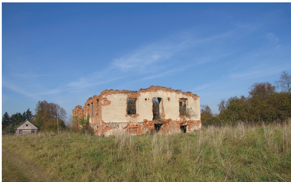
10. Podgrodzisk, gm. Suchowola. Ruiny dworu i dom mieszkalny od strony południowo-wschodniej, współcześnie. Fot. G. Ryżewski Podgrodzisk, Suchowola municipality. Ruins of a manor house and residential building on the south-eastern side, present day. Photo by G. Ryżewski
