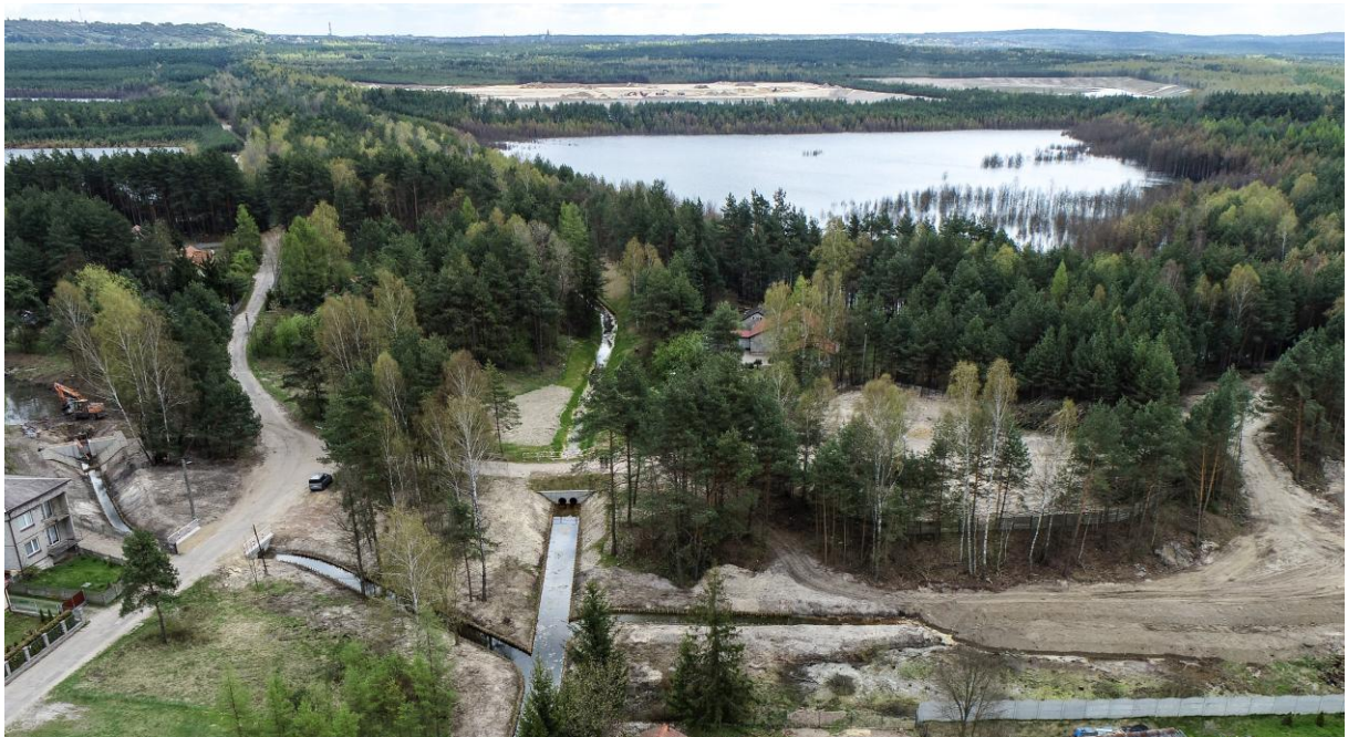
Ryc. 5. Widok z lotu ptaka na zalewisko Dąbrówka, roznos Sztolni Ponikowskiej oraz sieć kanałów i jazów spustowych do zrzutu wód z zalewisk (fot. OG PIG-PIB, 28.04.2026 r.)
