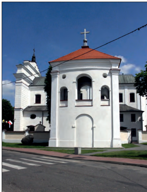
75. Międzyrzec Podlaski – dzwonnica przy kościele pw. św. Mikołaja, po pracach, fot. J. Maraśkiewicz, 2015.
