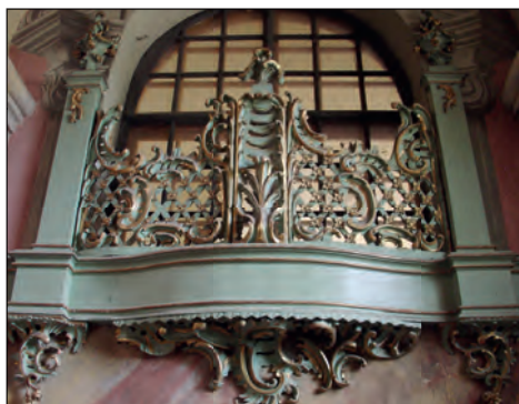
56. Włodawa, kościół rzymskokatolicki pw. św. Ludwika, balustrada okienna, stan przed konserwacją, fot. A. Lasek, 2012.
