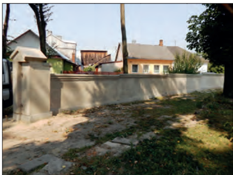
63. Wojsławice, ogrodzenie zespołu kościelnego, stan po remoncie, fot. S. Rudnik, 2015.
