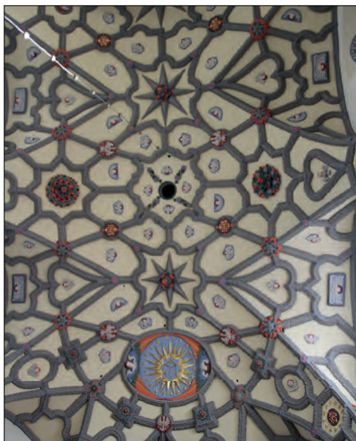
11. Czemierniki, kościół rzymskokatolicki, sklepienie prezbiterium po pracach, fot. J. Maraśkiewicz, 2015.
