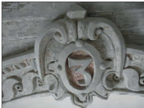
31. Lublin, Bazylika OO. Dominikanów, detal architektoniczny w kaplicy Firlejów w trakcie prac konserwatorskich, fot. M. Filip, 2015.
