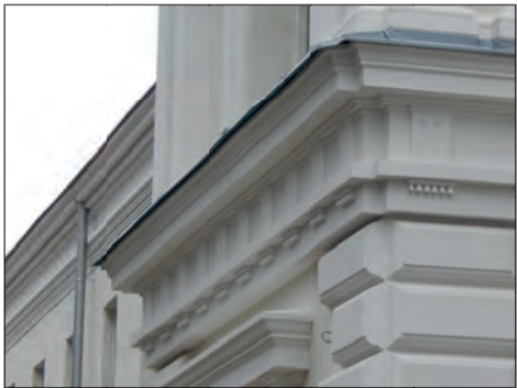
52. Chełm, ul. Hrubieszowska 102, d. szpital wojskowy, budynek d. administracji i sztabu, detal architektoniczny, w trakcie prac remontowych, fot. P. Wira, 2015.
