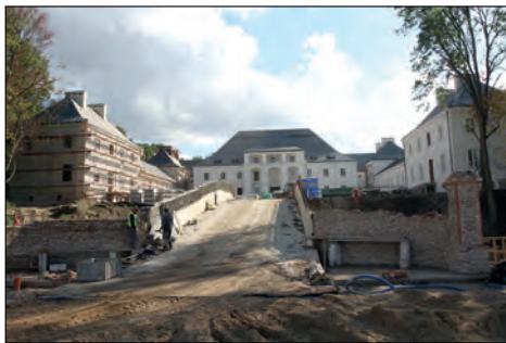
70. Janów Podlaski – zespół zamkowy, w trakcie prac remontowych i rewitalizacyjnych, fot. J. Maraśkiewicz, 2015.
