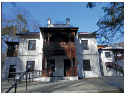
5. Nałęczów, Willa „Marianówka”, stan po remoncie, fot. A Kasiborski, 2016.
