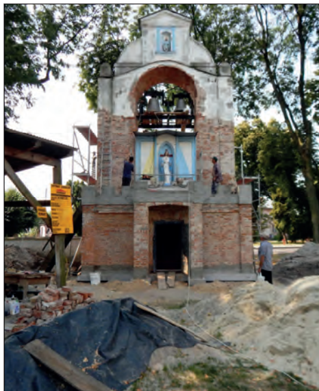
62. Wojsławice, dzwonnica kościelna, w trakcie remontu, fot. M. Pędzińska, 2015.
