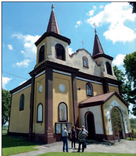
46. Buśno, kościół rzymskokatolicki pw. Wniebowzięcia NMP, przed rozpoczęciem remontu I etapu konstrukcji świątyni, fot. P. Wira, 2015.
