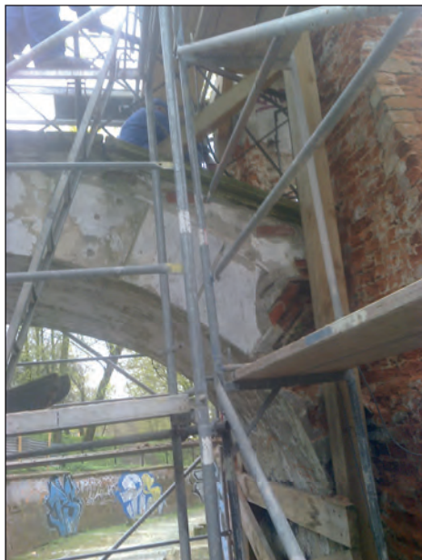
4. Mostek w trakcie prac remontowych. fot. PPKZ o/Lublin, 2016.
