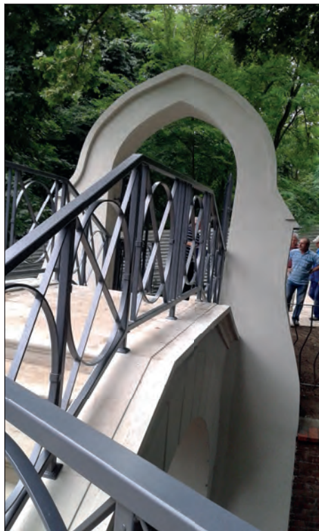
9. Fragment mostku po pracach konserwatorskich, fot. A. Wiśniewska, 2016.
