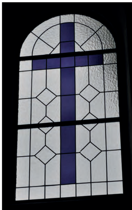
10. Lublin, kościół św. Jakuba, okno nawy po konserwacji, fot. K. Tur-Marciszuk, 2015.
