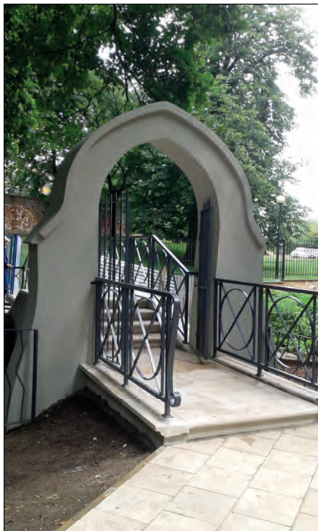
8. Fragment mostku po pracach konserwatorskich, fot. A. Wiśniewska, 2016.
