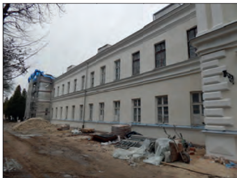
50. Chełm, ul. Hrubieszowska 102, d. szpital wojskowy, budynek d. administracji i sztabu, w trakcie prac remontowych, fot. P. Wira, 2015.
