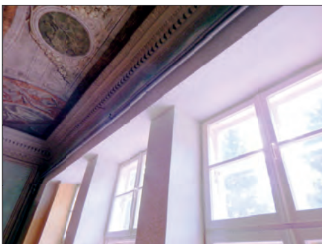
57. Surhów, pałac, nadproże sali „białej” po remoncie, fot. S. Rudnik, 2015.
