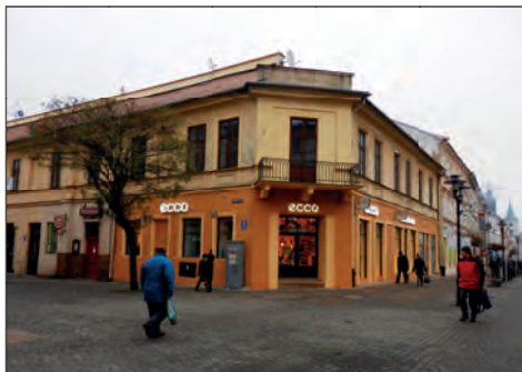
19. Lublin, Kamienica przy ul. Krakowskie Przedmieście 25, widok elewacji przed remontem, fot. A. Wiśniewska, 2014.
