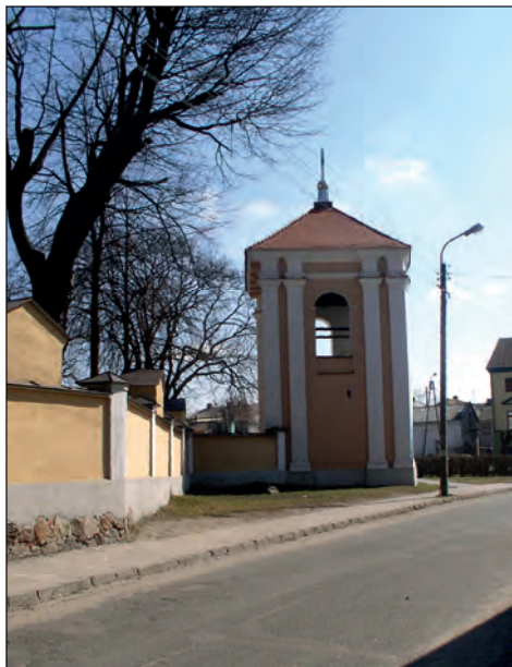
74. Międzyrzec Podlaski – dzwonnica przy kościele pw. św. Mikołaja, przed remontem, fot. J. Maraśkiewicz, 2013.
