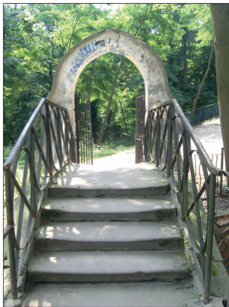
3. Fragment mostku przed podjęciem prac konserwatorskich, fot. M. Kurczewicz, 2015.
