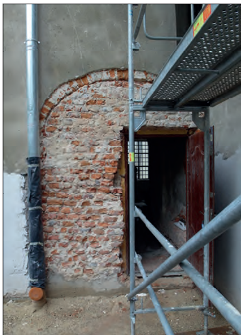
9. Kaplica MB Paryskiej – zarys pierwotnego wejścia od strony elewacji, fot. M. Filip, 2015.
