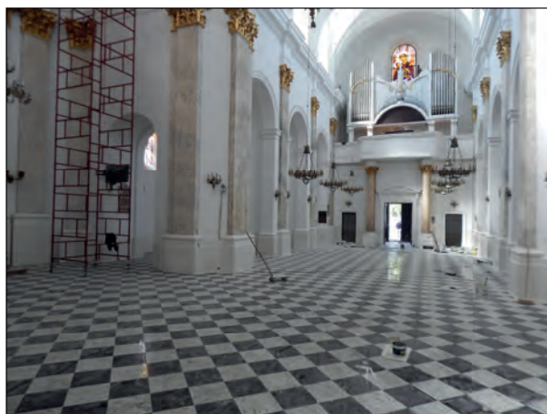
49. Chełm, bazylika pw. Narodzenia NMP, remont posadzki, po zakończeniu prac, fot. P. Wira, 2015.
