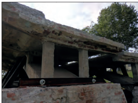
5. Ustrój konstrukcyjny mostu, wydobyty z nasypu drogi Łabunie Reforma – Polanówka, przeniesiony na teren przy ul. Nadbystrzyckiej 38 w Lublinie, fot. A. Frąckiewicz, 2015.
