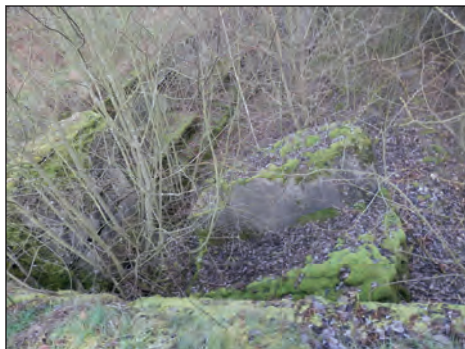
6. Koroszczyn, fort „O”, widok na stanowiska i przelotnie przed pracami, fot. P. Zieniuk, 2015
