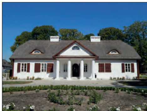
58. Krasnystaw, dwór „Starostwo”, stan po remoncie, fot. P. Wira, 2015.
