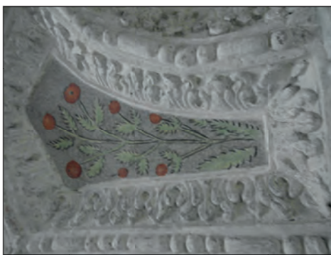
24. Lublin, Bazylika OO. Dominikanów, po- lichromie w kaplicy Ossolińskich w trakcie konserwacji, fot. M. Filip, 2015.
