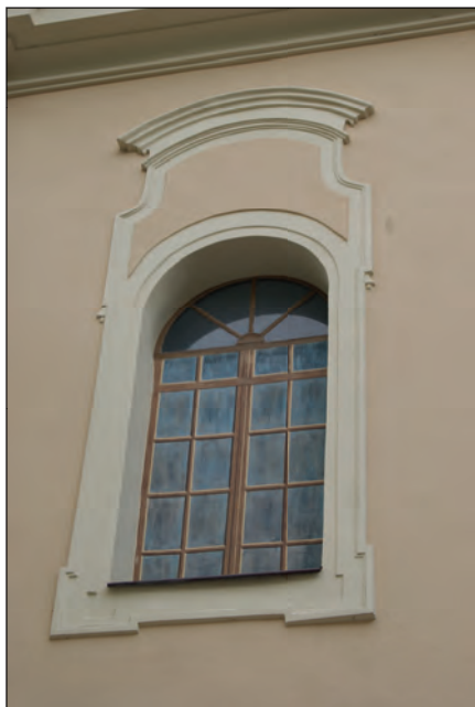
7. Końskowola, kościół parafialny, okno malowane na fasadzie po konserwacji, fot. K. Tur-Marciszuk, 2015.
