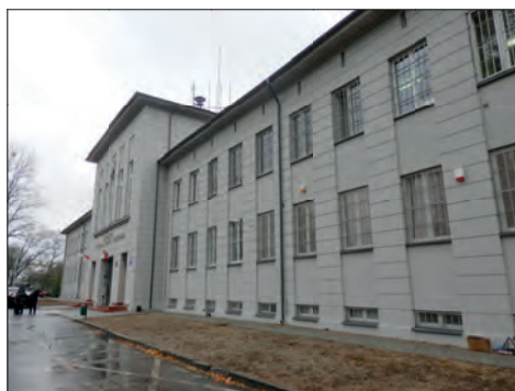
8. Dęblin, Komendantura Szkoły Lotniczej, elewacja frontowa po remoncie, fot. M. Kurczewicz, 2015.
