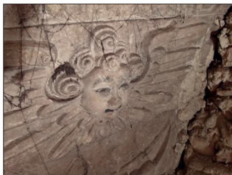
28. Lublin, Bazylika OO. Dominikanów, odkryty w trakcie prac łuk w kaplicy Ossolińskich przed konserwacją, fot. M. Filip, 2015.
