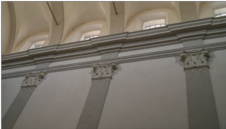
6. Ściana boczna nawy głównej po pracach konserwatorskich, m.in. przy dekoracji architektonicznej w postaci kapiteli pilastrów i gzymsowania., fot. B. Stolarz, 2015.
