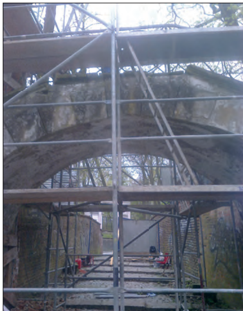
5. Mostek w trakcie prac remontowych. fot. PPKZ o/Lublin, 2016.
