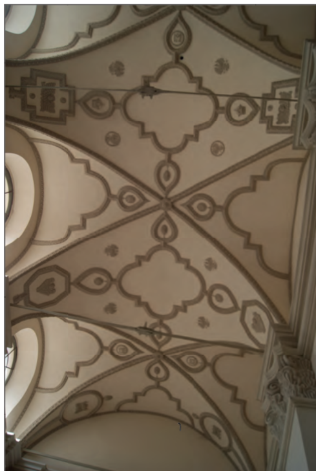
4. Sklepienie nawy bocznej po pracach konserwatorskich, fot. B. Stolarz, 2015.
