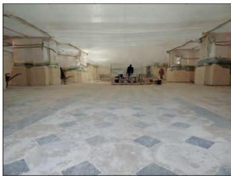
48. Chełm, bazylika pw. Narodzenia NMP, remont posadzki, fot. P. Wira, 2015.
