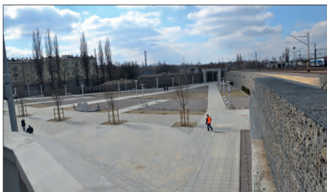
6. Skwer przy wiadukcie kolejowym przy ul. Kunickiego, po remoncie, fot. M. Gałęcka, 2016.
