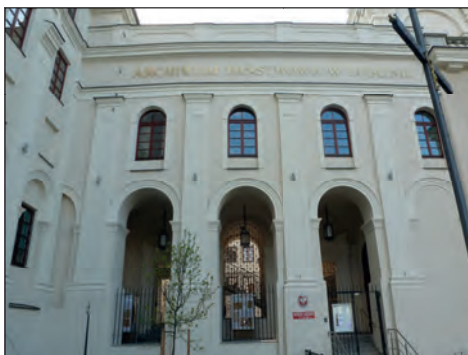
12. Lublin, ul. Jezuicka 13, budynek d. szkół jezuickich, fasada po remoncie, fot. A. Frąckie-wicz, 2016.
