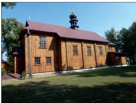
35. Nielisz, kościół parafialny pw. św. Wojciecha, po pracach remontowych, fot. J. Wyczółkowski, 2015.
