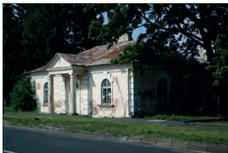
43. Zamość, Belwederek, budynek przed rozpoczęciem prac remontowych, fot. L. Kuśmierz, 2015.
