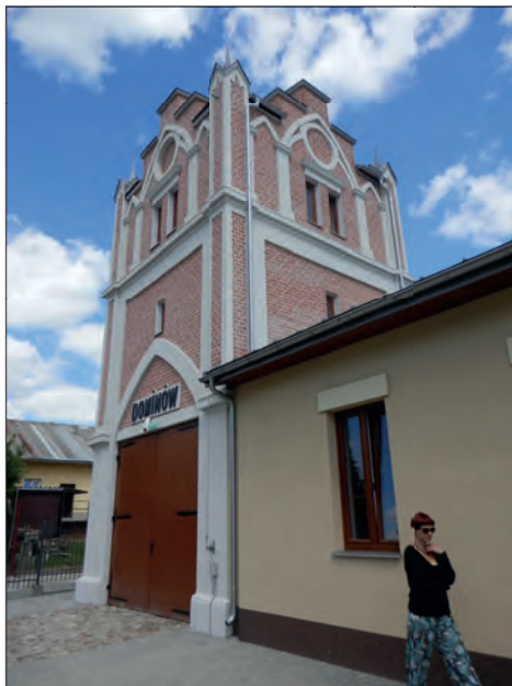
2. Dominów, Wieża – brama wjazdowa w zespole dworsko – parkowym, stan po remoncie, fot. E. Podkościelny, 2015.
