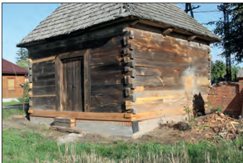
78. Rudno – dzwonnica przy kościele parafialnym pw. Przemienienia Pańskiego, w trakcie remontu, fot. J. Maraśkiewicz, 2015.
