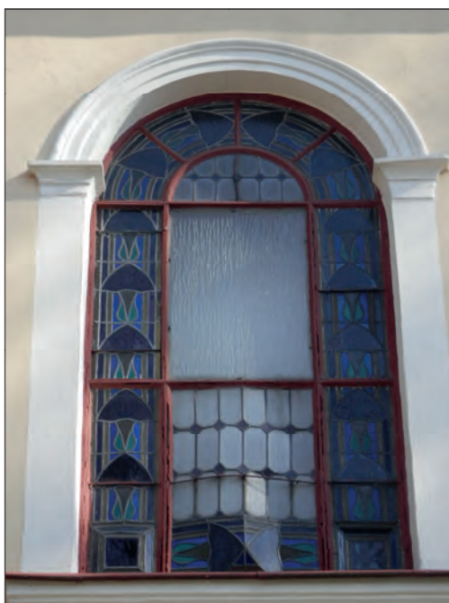
4. Krzczonów, kościół parafialny, okno witrażowe z odkształceniem, fot. K. Tur-Marciszuk, 2015.
