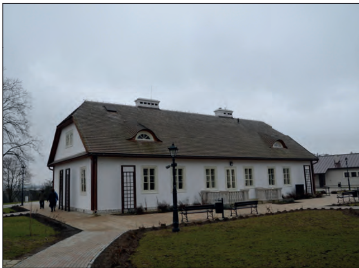
4. Krasnystaw, dwór w zespole „Starostwo” po remoncie, elewacja ogrodowa, fot. A. Frąckiewicz, 2016.
