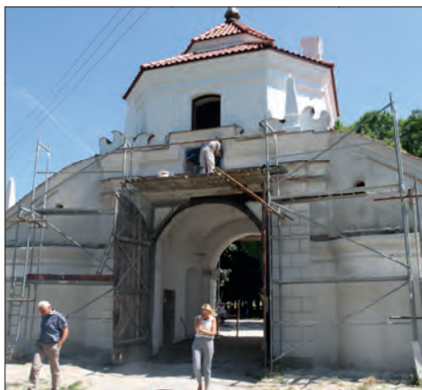
67. Czemierniki – zespół zamkowy, brama wjazdowa w trakcie remontu, fot. J. Maraśkiewicz, 2015
