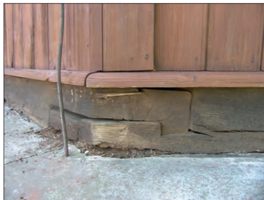
10. Łączenie podwalin na narożach, fot. St. Rudnik, 2016.
