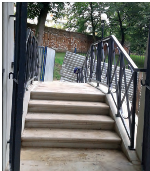
10. Fragment mostku po pracach konserwatorskich, fot. A. Wiśniewska, 2016.
