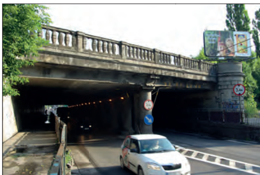
2. Wiadukt kolejowy przy ul. Kunickiego w Lublinie, przed remontem, 2009.
