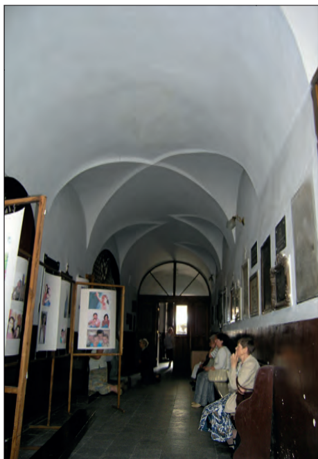
7. Kruchta kościoła przed pracami konserwatorskimi, fot. B. Stolarz, 2015.
