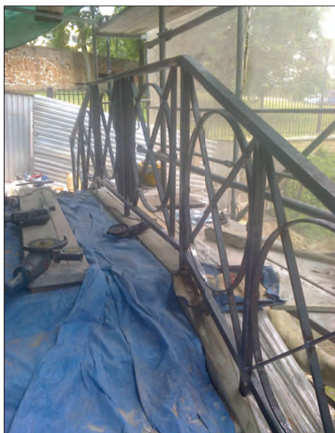
7. Mostek w trakcie prac remontowych. fot. PPKZ o/Lublin, 2016.
