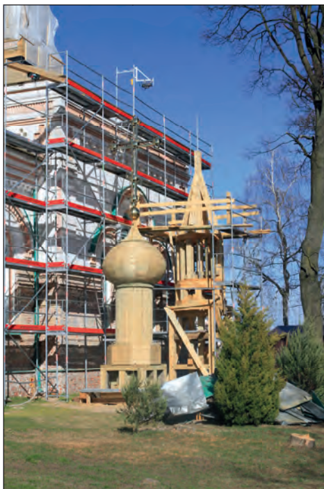
72. Kobylany - cerkiew prawosławna pw. Opieki MB, w trakcie rekonstrukcji kopuł, fot. J. Maraśkiewicz, 2015
