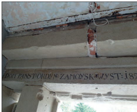
54. Szczepieszyń, zespół szkolny, portal wejściowy oficyny od strony wschodniej, stan w trakcie konserwacji, fot. M. Filip, 2015.
