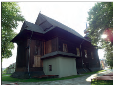
33. Tomaszów Lubelski, kościół parafialny pw. Zwiastowania NMP, elewacja wschodnia i południowa w trakcie konserwacji, fot. M. Filip, 2015.
