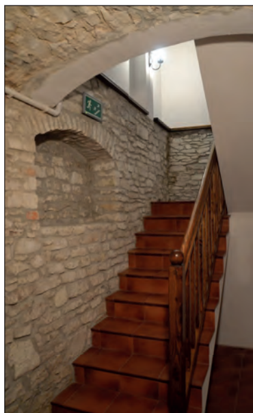
5. Krasnystaw, dwór w zespole „Starostwo” piwnice po remoncie, fot. A. Frąckiewicz, 2016.
