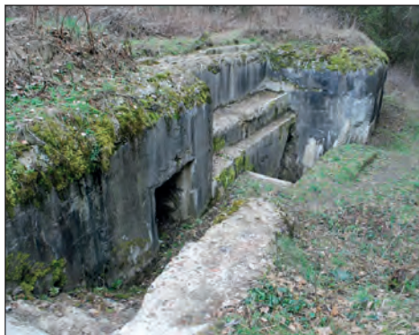
2. Koroszczyn, fort „O”, kazamaty przedpiersia wału po pracach, fot. P. Zieniuk, 2015.
