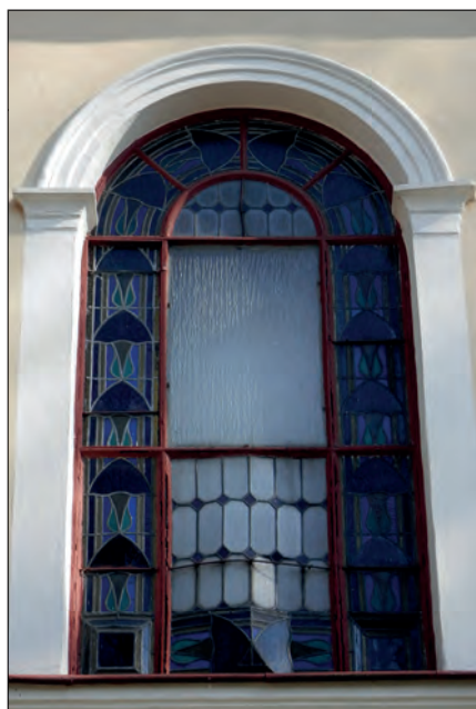
9. Krzczonów, okno witrażowe w fasadzie kościoła pw. Wniebowzięcia NMP, fot. K. Tur-Marciszek, 2015.
