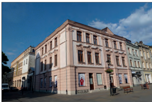
14. Lublin, Kamienica przy ul. Krakowskie Przedmieście 20, elewacja po remoncie, fot. A. Frąckiewicz 2016.
