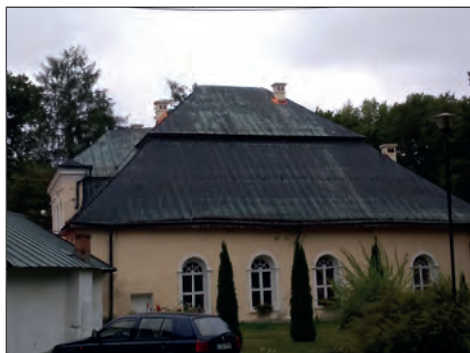
36. Krasnobród, pałac w zespole pałacowo-parkowym, po pracach remontowych kominów, fot. A. Cieplichowicz, 2015.
