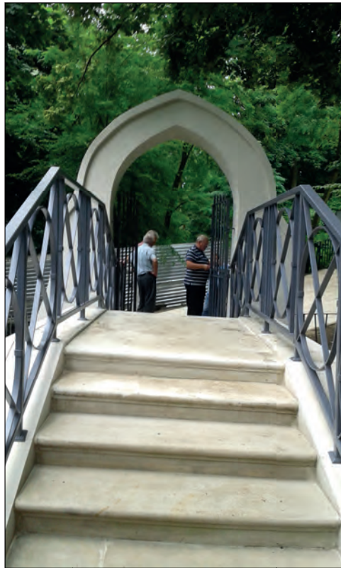
11. Fragment mostku po pracach konserwatorskich, fot. A. Wiśniewska, 2016.
