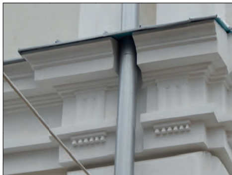
53. Chełm, ul. Hrubieszowska 102, d. szpital wojskowy, budynek d. administracji i sztabu, detal architektoniczny, w trakcie prac remontowych, fot. P. Wira, 2015.
