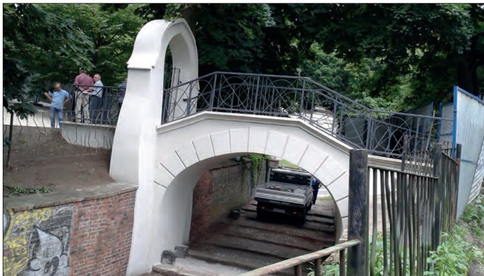
12. Mostek po pracach konserwatorskich, fot. A. Wiśniewska, 2016.
