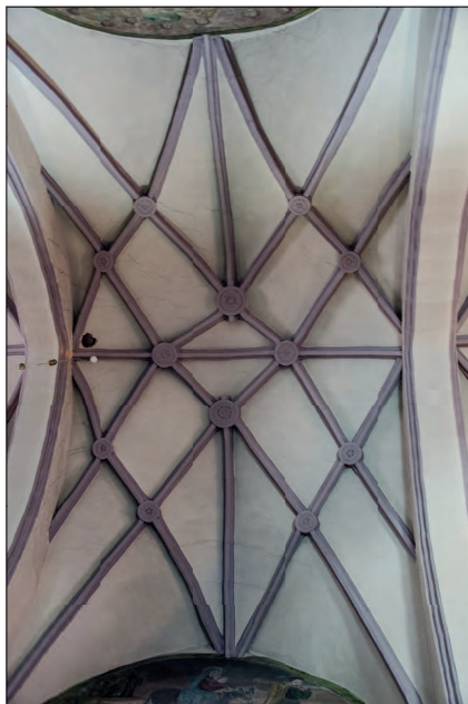
3. Kraśnik, Kościół paraf. pw. Wniebowzięcia NMP w zespole d. kościoła i klasztoru kanoników regularnych, nawa główna kościoła, stan przed konserwacją, fot. K. Tur-Marciszek, 2015.
