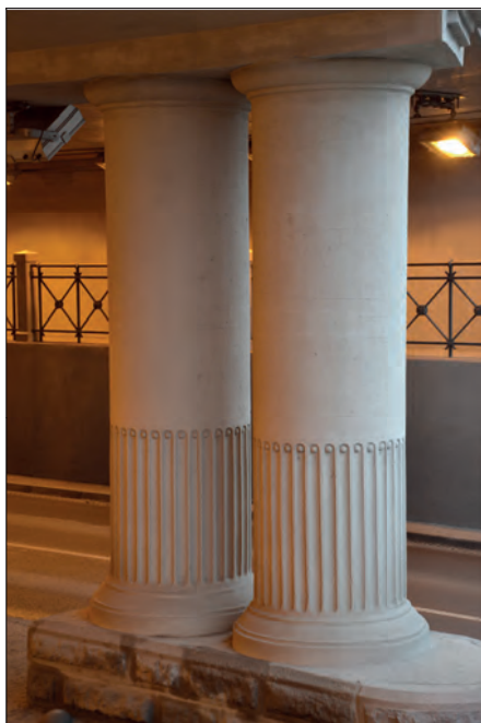
8. Lublin, wiadukt kolejowy po remoncie, kolumny, fot. K. Rutkowski, 2016.
