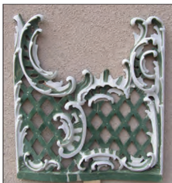
57. Włodawa, kościół rzymskokatolicki pw. św. Ludwika, balustrada okienna, detal, w trakcie konserwacji, fot. A. Lasek, 2015.
