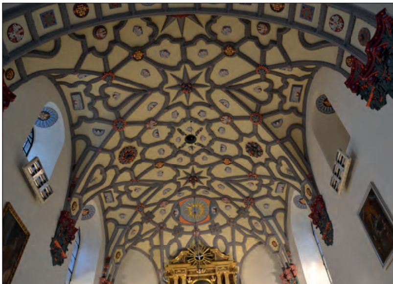
1. Czemierniki, kościół parafialny, sklepienie prezbiterium po konserwacji, fot. D. Kopciowski, 2016.
