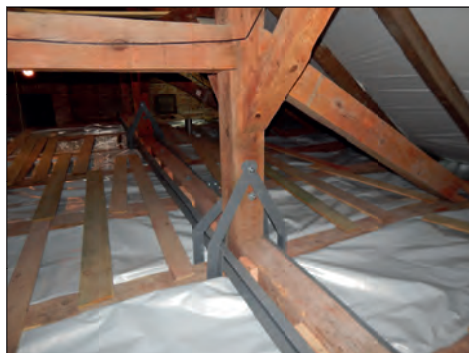
47. Buśno, kościół rzymskokatolicki pw. Wniebowzięcia NMP, konstrukcja dachu po remoncie, fot. M. Pędzińska, 2015.
