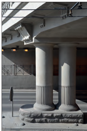
5. Wiadukt kolejowy przy ul. Kunickiego w Lublinie, po remoncie, fot. M. Gałęcka, 2016.
