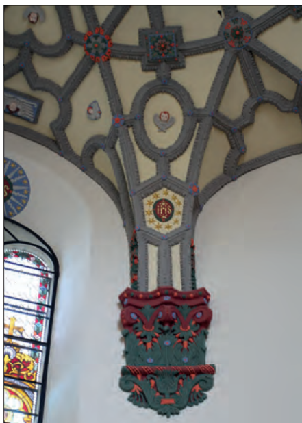
12. Czemierniki, kościół rzymskokatolicki, fragm. sklepienia prezbiterium po pracach, fot. J. Maraśkiewicz, 2015.
