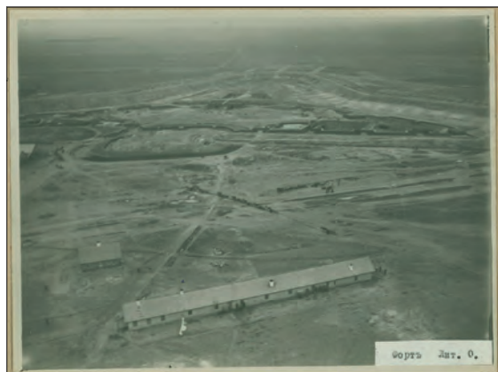
8. Koroszczyn, fort „O”, zdjęcie lotnicze fortu w trakcie budowy od strony wsch., fot. archiwum WUOZ Lublin/Biała Podl.
