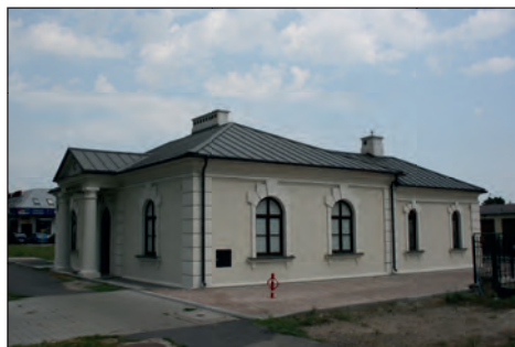
44. Zamość, Belwederek, budynek po zakończeniu prac remontowych, fot. L. Kuśmierz, 2015.
