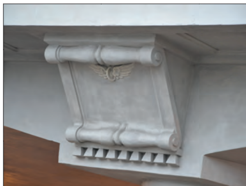
9. Lublin, wiadukt kolejowy po remoncie, detal, fot. K. Rutkowski, 2016.
