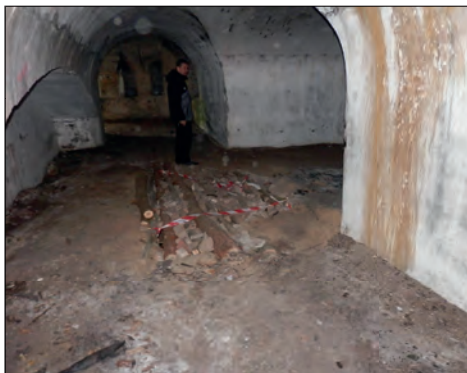
4. Koroszczyn, fort „O”, zabezpieczenie otworu, fot. P. Zieniuk, 2015.
