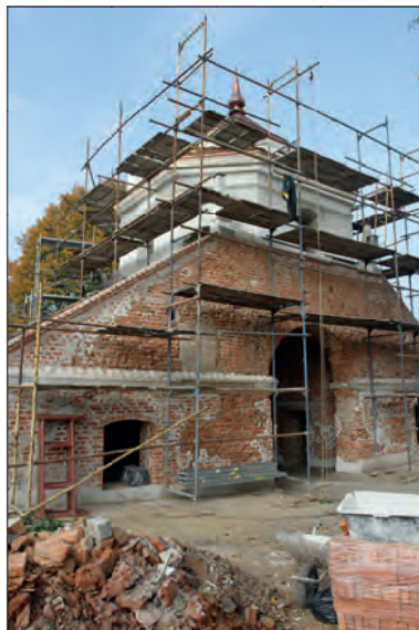
66. Czemierniki – brama główna zespołu zamkowego, w trakcie remontu, fot. J. Maraśkiewicz, 2015.
