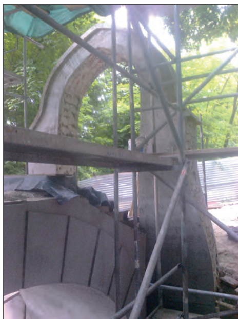
6. Mostek w trakcie prac remontowych. fot. PPKZ o/Lublin, 2016.
