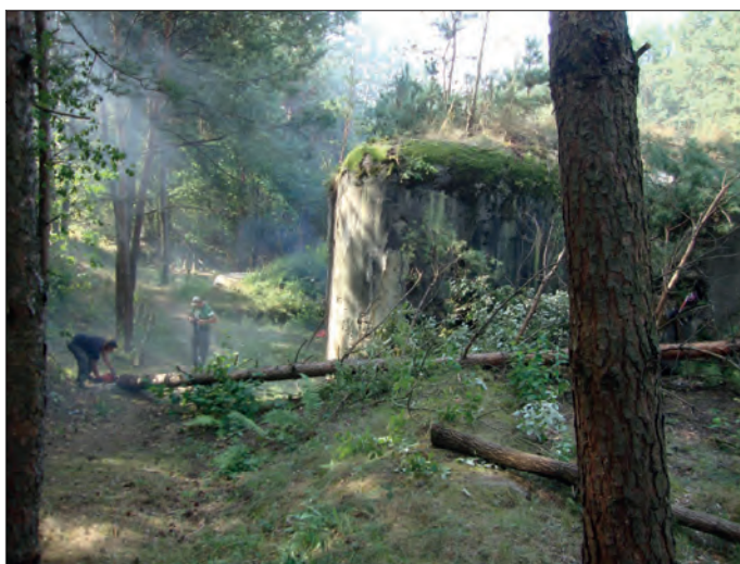
5. Koroszczyn, fort „O”, prace na obiekcie, fot. K. Niczyporuk, 2015.
