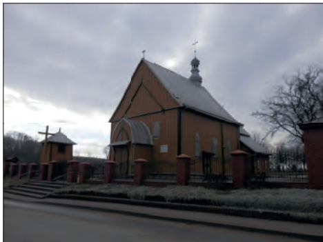
10. Blinów Drugi, Kościół parafialny, widok kościoła po remoncie elewacji, fot. K. Tur-Mar-ciszuk, 2015.
