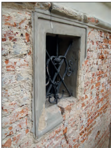
38. Uchanie, kościół parafialny pw. Wniebowzięcia NMP, elewacja północno-wschodnia zakrystii w trakcie prac konserwatorskich, fot. M. Trocha, 2015.
