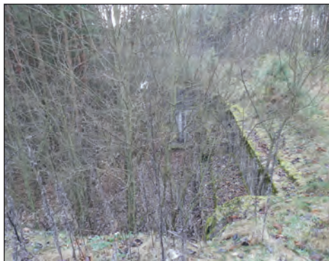
1. Koroszczyn, fort „O”, kazamaty przedpiersia wału przed pracami, fot. P. Zieniuk, 2015.
