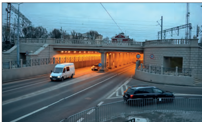
7. Wiadukt kolejowy przy ul. Kunickiego w Lublinie, po remoncie, fot. K. Rutkowski, 2016.
