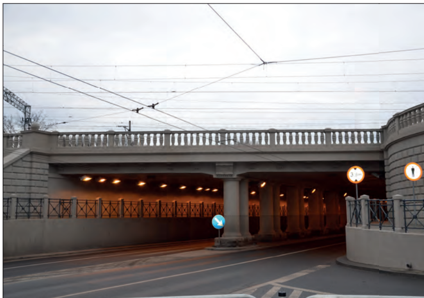
7. Lublin, wiadukt kolejowy po remoncie, widok z ul. Kunickiego, fot. K. Rutkowski, 2016.
