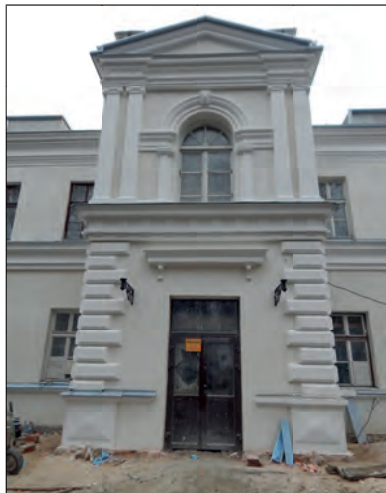
51. Chełm, ul. Hrubieszowska 102, d. szpital wojskowy, budynek d. administracji i sztabu, w trakcie prac remontowych, fot. P. Wira, 2015.
