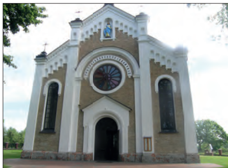
45. Nabroż, kościół parafialny pw. Wniebowzięcia NMP, w trakcie prac, fot. L. Kuśmierz, 2015.
