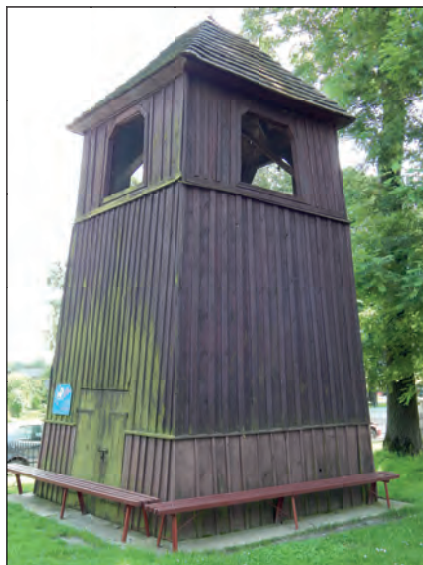
64. Żmudź, dzwonnica kościelna, stan przed remontem, fot. M. Pędzińska, 2015.
