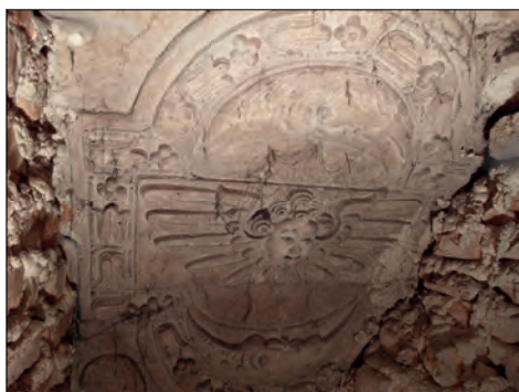
29. Lublin, Bazylika OO. Dominikanów, odkryty w trakcie prac łuk w kaplicy Ossolińskich przed konserwacją, fot. M. Filip, 2015.
