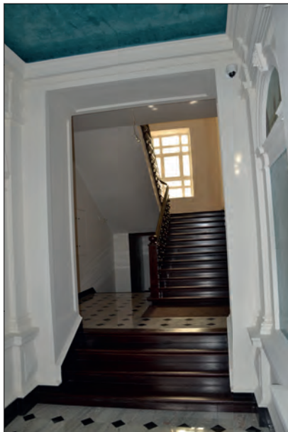
16. Lublin, ul. Krakowskie Przedmieście 51, sień i klatka schodowa kamienicy po remoncie, fot. D. Kopciowski, 2016.
