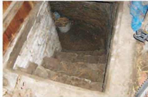
Brak poręczy i zabezpieczeń (fot. OR Lublin)
