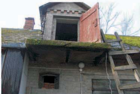
Drabiny nie spełniające wymogów bezpieczeństwa (fot. OR Kielce, OR Zielona Góra, OR Lublin, OR Warszawa)
