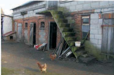
Brak poręczy i zabezpieczeń (fot. OR Lublin)
