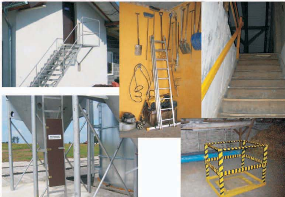
Właściwa konstrukcja schodów i drabin, barierki ochronne i zabezpieczenia otworów zrzutowych chronią przed upadkiem z wysokości
