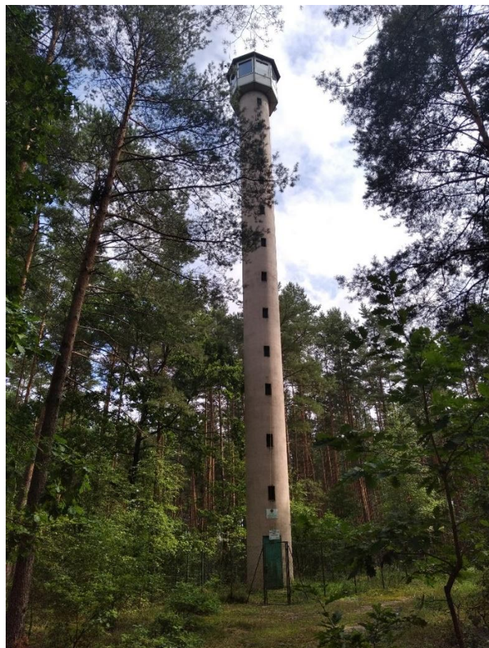
Zdjęcie 18. DOSTRZEGALNIA PRZECIWPOŻAROWA W LEŚNICTWIE RYTWINY (FOT. M. DROZD)
