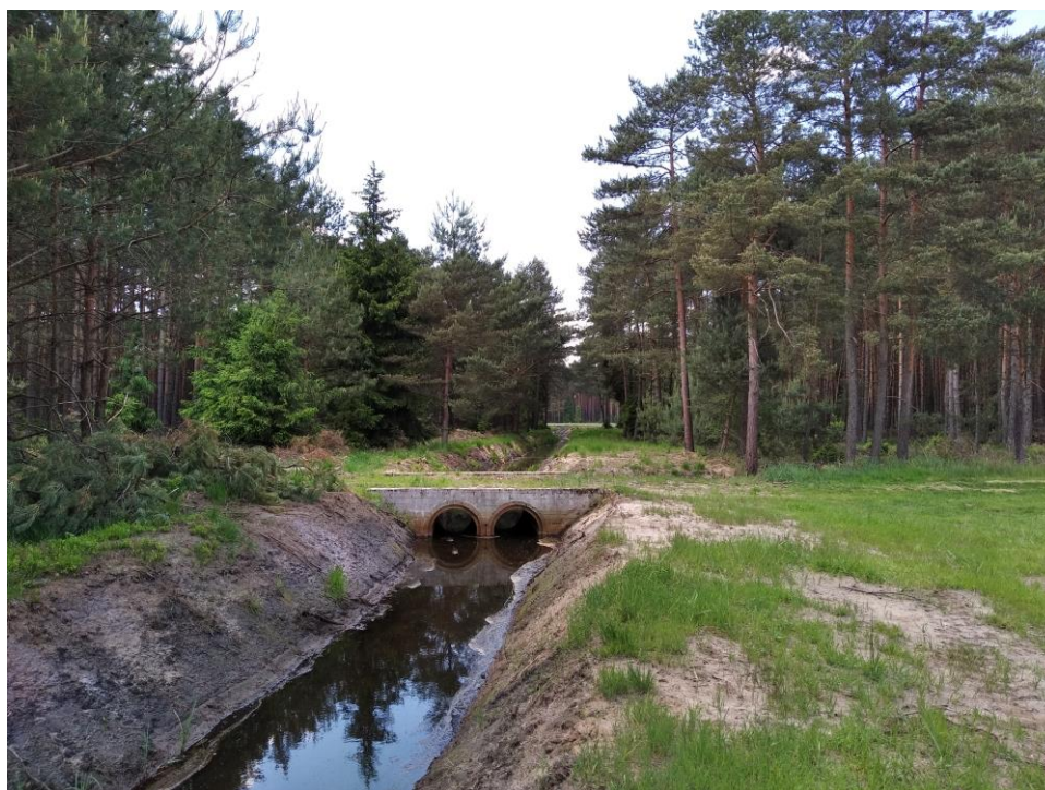
Zdjęcie 23. PRZEPUSTY NA NATURALNYM CIEKU WODNYM „ŻELAZNA” W LEŚNICTWIE ZARZECZE (FOT. M. DROZD)
