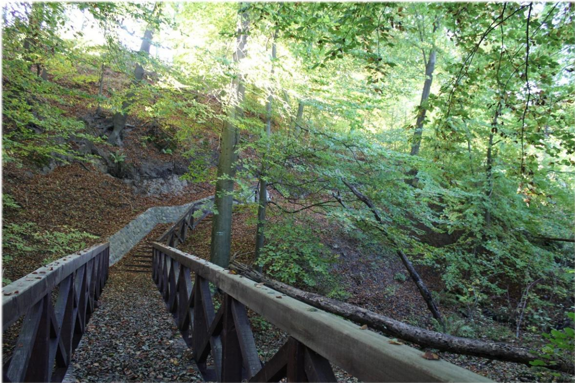
Fig. 56 Infrastruktura na Leśnej Ścieżce edukacyjnej w leśnictwie Swobnica (fot. N. Sokołowska)
