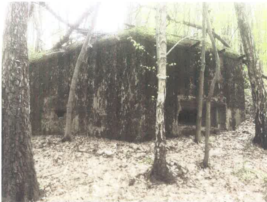
zdj. 1 – ściany boczne obiektu
