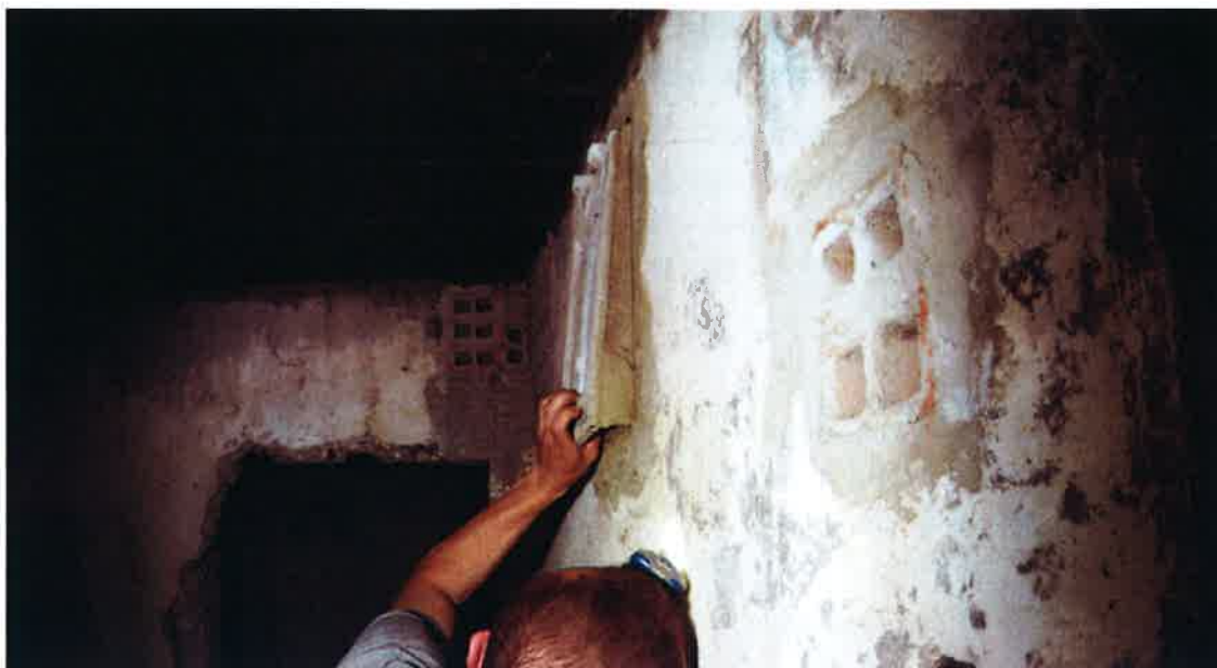
zdj. 11 – wykonanie schronień z dachówek
