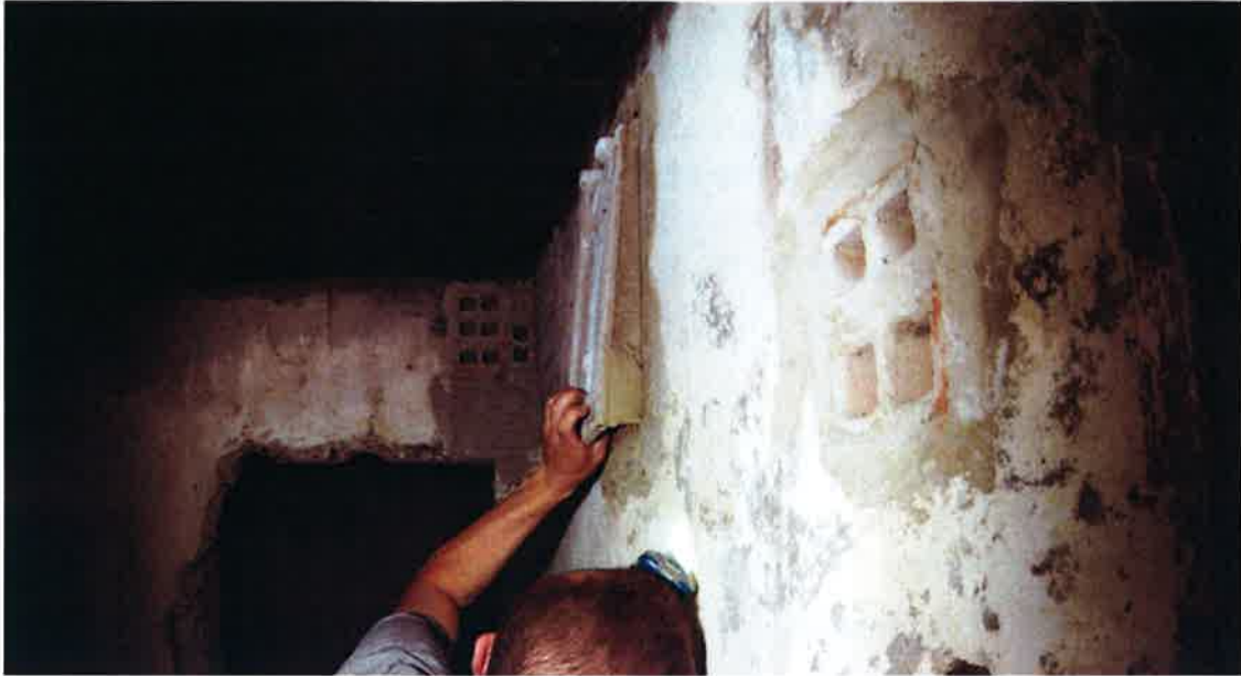
zdj. 11 – wykonanie schronień z dachówek
