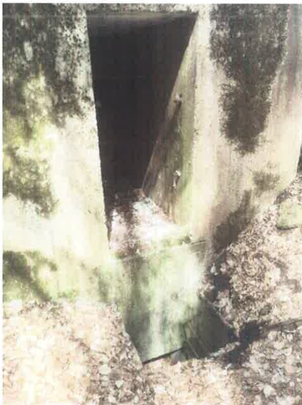
zdj. 4 – wejście do obiektu wraz z kanałem ewakuacyjnym
