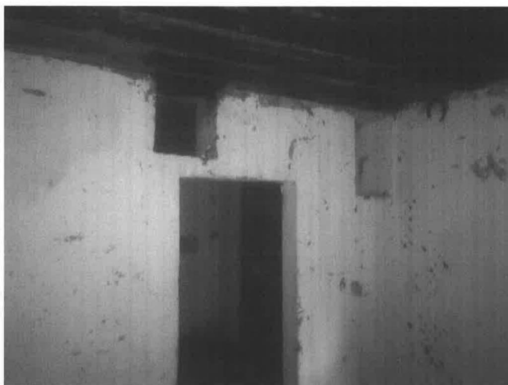
zdj. 6 – przejście między pomieszczeniami
