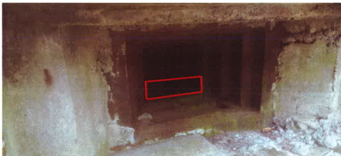
zdj. 12 – miejsce montażu stalowych płytek w otworach strzelniczych pomieszczenia nr 6 i 8
