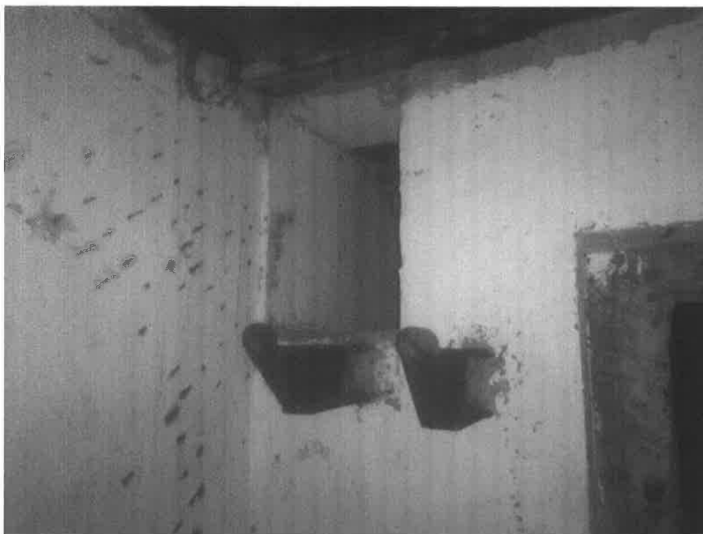
zdj. 5 – otwór między pomieszczeniami
