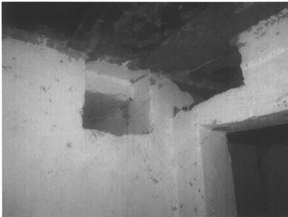
zdj. 8 – otwory między pomieszczeniami
