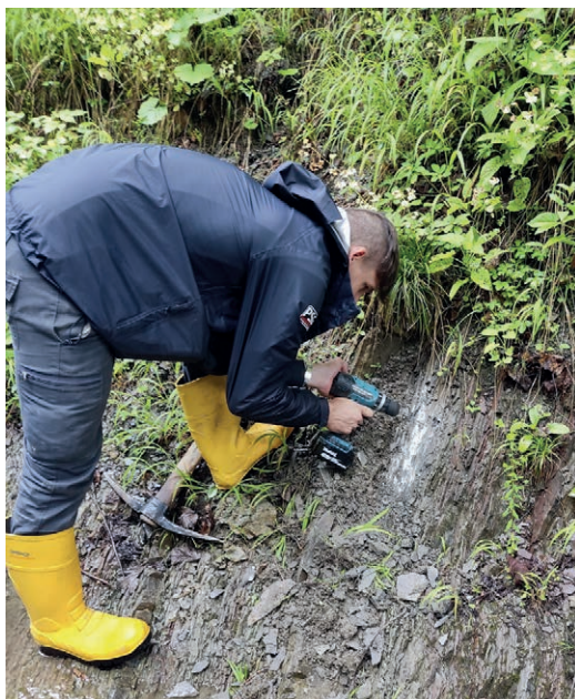
Ryc. 9. Wiercenie otworu pod sondę igłową w łupkach fliszowych
