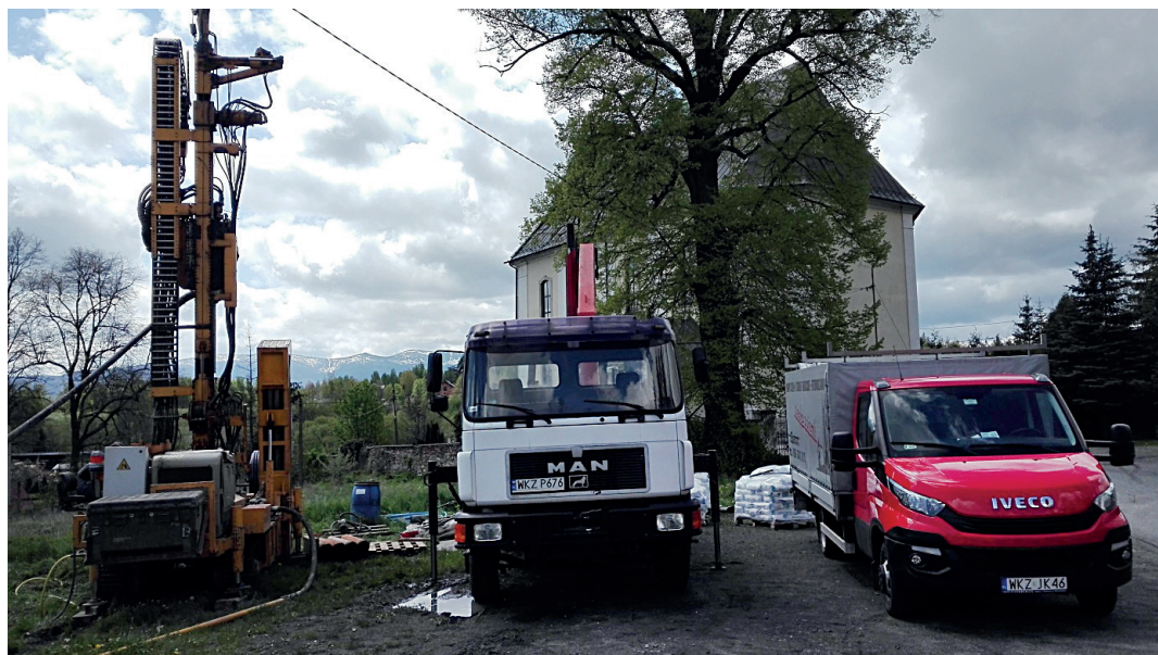
Ryc. 20. Wiercenie termopiezometru TP-1 Wojcieszce
