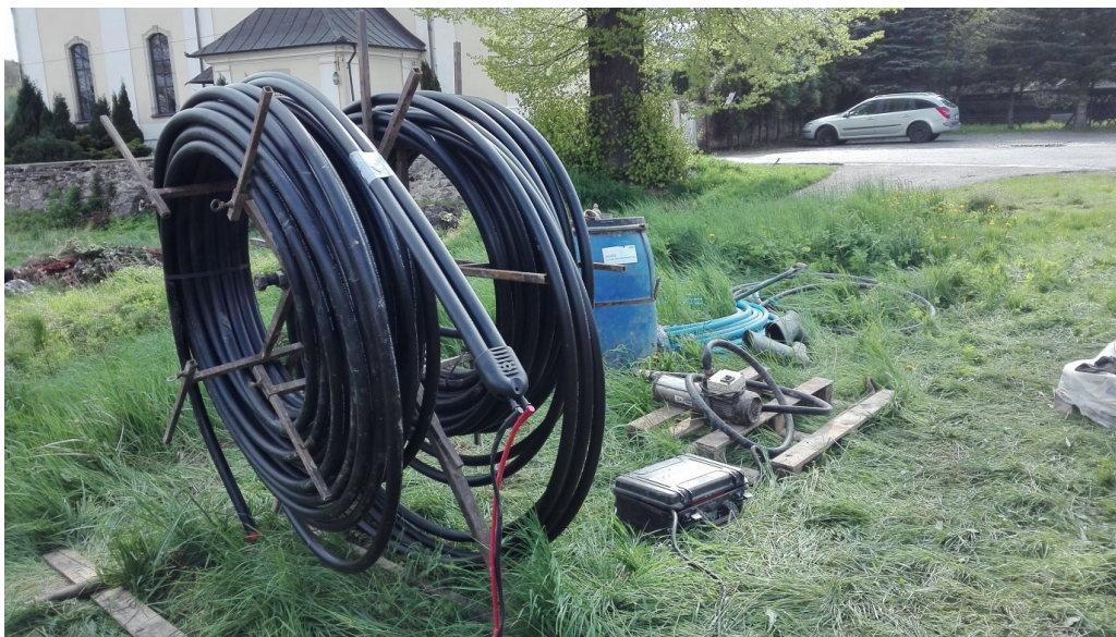
Ryc. 21. Przygotowanie otworowego wymiennika ciepła do zapuszczenia do otworu
