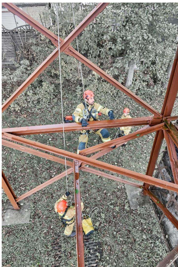
rys. 28 Wychodzenie z asekuracją od góry
