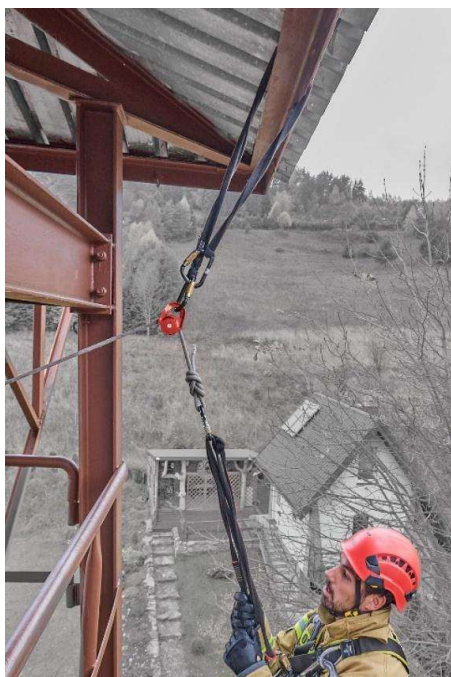
rys. 17 Zakładanie stanowiska na konstrukcji, stosowanego do układów ratowniczych, technika 1 i 2 lin
