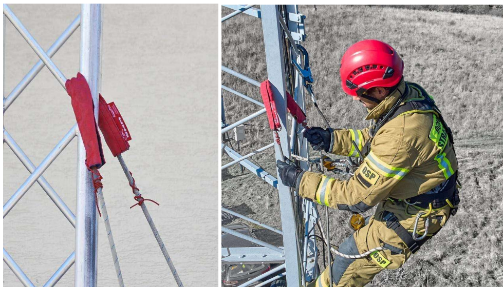
rys. 33 Założona ochrona liny
