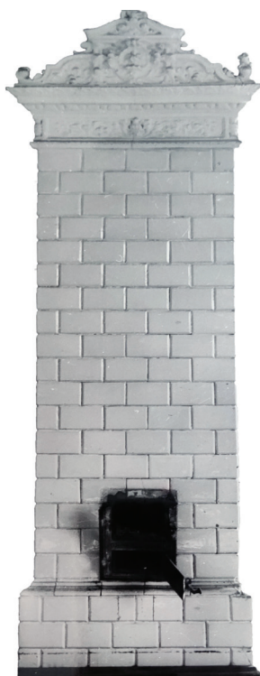
3. Białystok, ul. Dojlidy Fabryczne 23, Wojewódzki Urząd Ochrony Zabytków w Białymstoku (dawny pałac Hasbacha). Piec z kafli kwadratowych w pomieszczeniu na I piętrze, fot. W. Wawrzonkowski, 1973, niezachowany. PP PKZ Oddział w Białymstoku, Białystok-Dojlidy, Pałac Hasbacha, Dokumentacja historyczno-architektoniczna , oprac. M. Dolistowska, fot. E. Solbut, Białystok 1980
