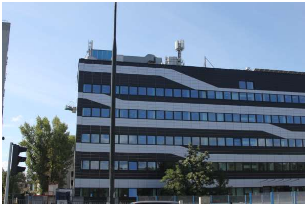
Fot. 1a, b, c: Widoki anten stacji bazowych: ID: WAR1149A, ID: (80968N!) GOLESZOWSKA_NEW, ID: BT 13899 Wolska Bis Temp zlokalizowanych przy ul. Golezowskiej 6 w Warszawie
