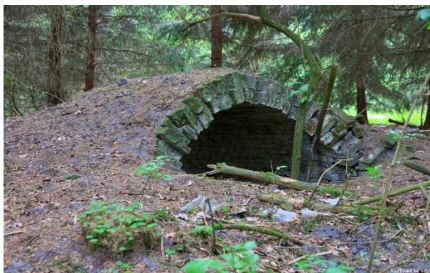
Fotografia 30: Ugoszcz, piwnica przy nieistniejącej leśniczówce, leśn. Ugoszcz, oddział 127
