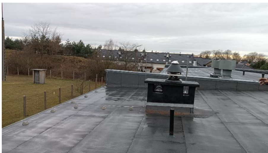
Zdjęcie nr 2: Remont połączeni dachowej, SUW Karczma Borowa.
