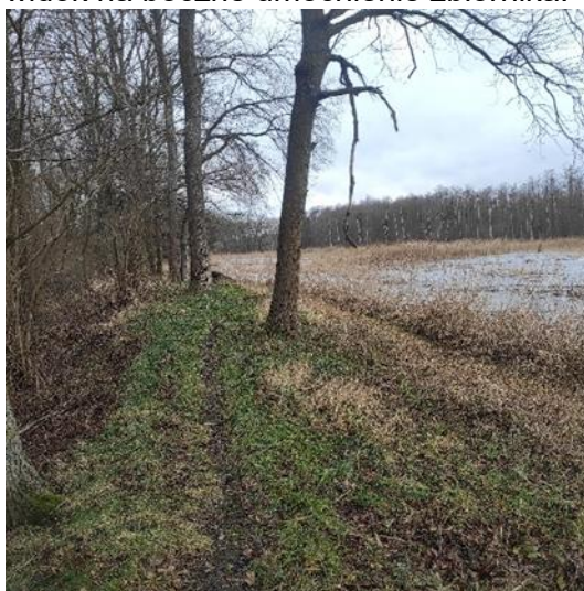
Zbiornik k. m. Niemstów - 2020 r. – widok na boczne umocnienie zbiornika.
