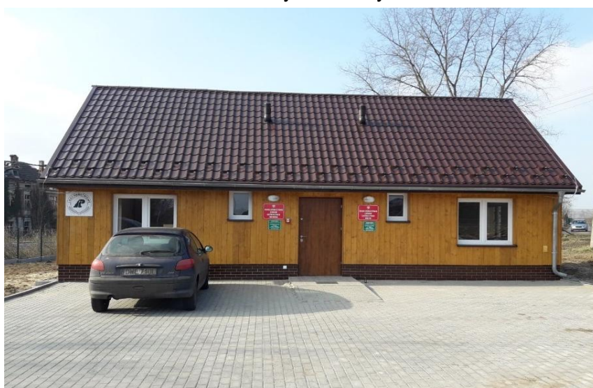
Budynek kancelarii leśnictwa Orsk - Rudna wybudowany w 2018 r.
