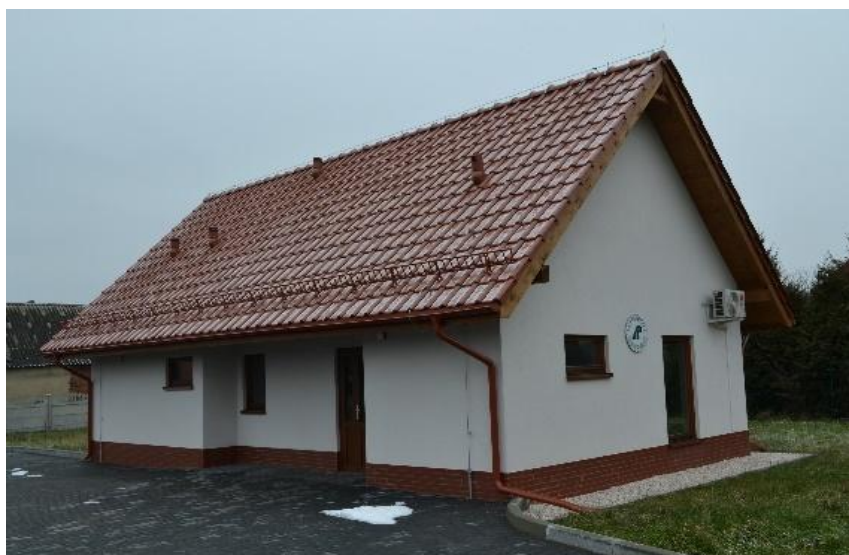
Budynek kancelarii leśnictwa Tymowa - Małomice wybudowany w 2020 r.
