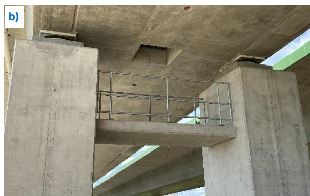
Rys. 8.5.1. Przykłady galerii zlokalizowanych na głowicach filarów: a) rozwiązanie zalecane – swobodny dostęp do głowicy filara i łożysk, b) rozwiązanie niezalecane – dostęp ograniczony
