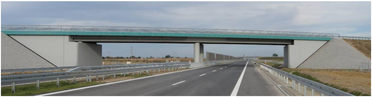
Rys. 4.9.1. Przykład poprawnie dobranej kolorystyki drogowego obiektu inżynierskiego
