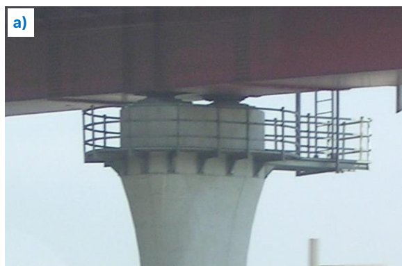
Rys. 8.5.1. Przykłady galerii zlokalizowanych na głowicach filarów: a) rozwiązanie zalecane – swobodny dostęp do głowicy filara i łożysk, b) rozwiązanie niezalecane – dostęp ograniczony
