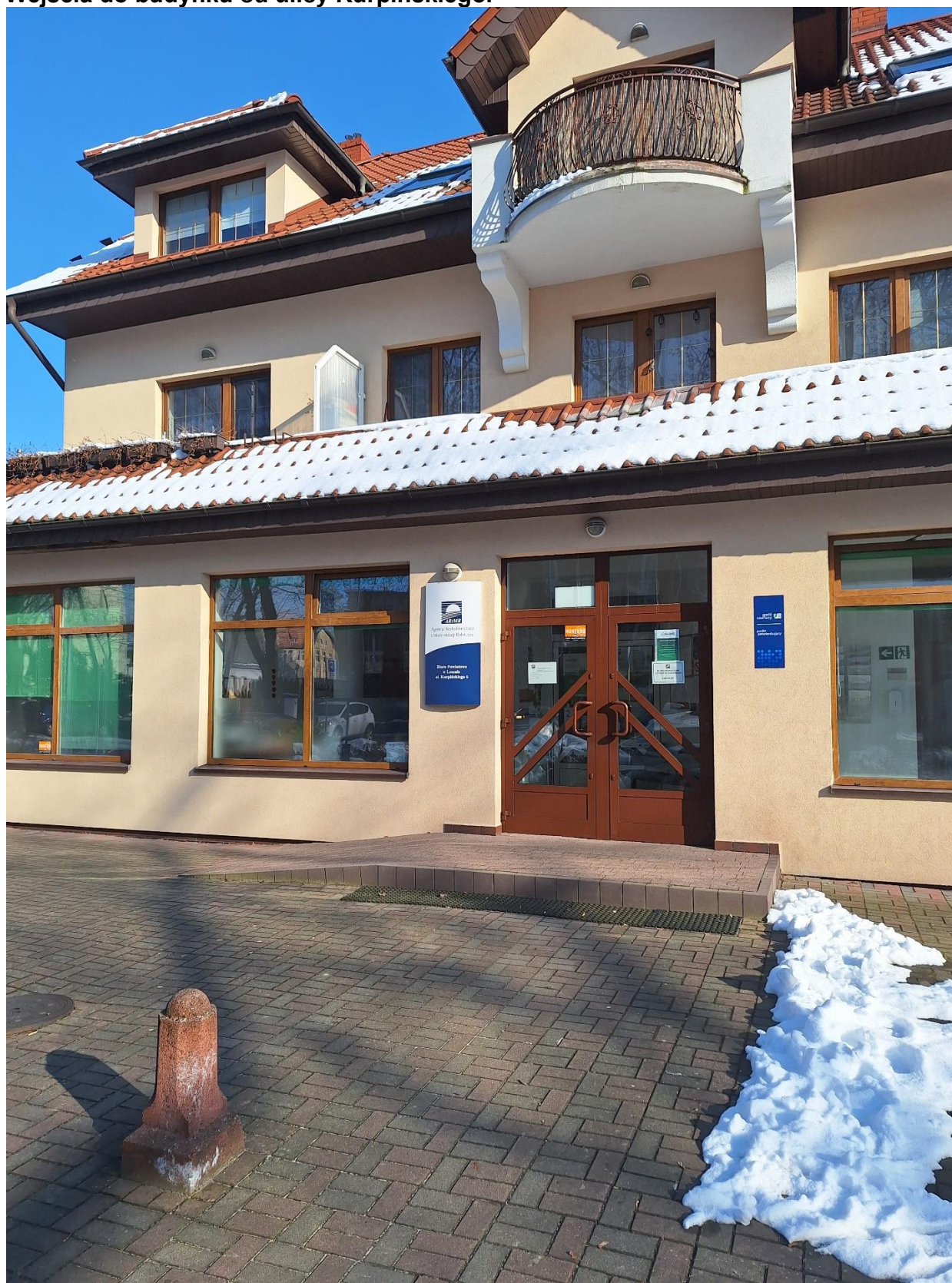
Wejścia do budynku od ulicy Kurpińskiego.
