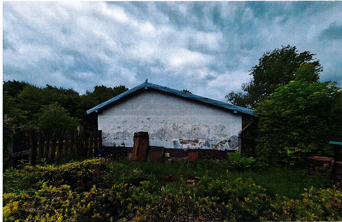
Fot. 5 Elewacja boczna
