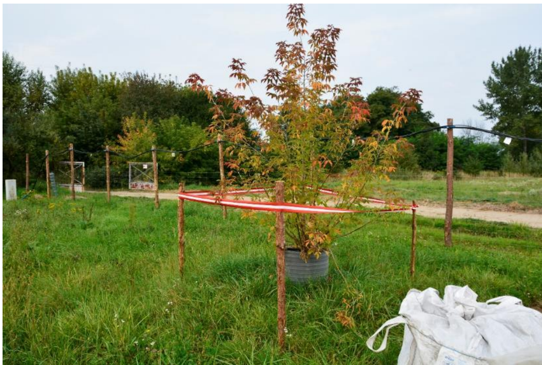
Fot. 5. Kontrola strefy zaplecza budowy Wykonawcy, widok na wykonane wygradzenia zieleni (2. dekada września 2021 r.).
