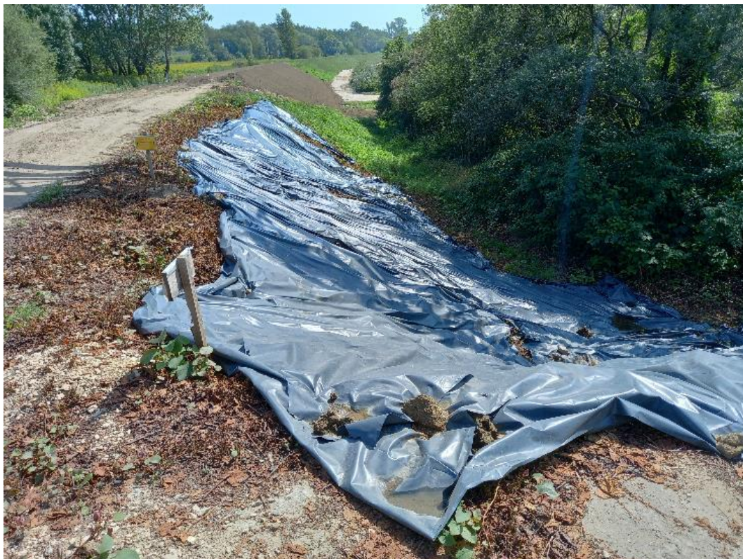
Fot. 12. Wał prawy, km ok. 0+900 – przykład działań ograniczania rozwoju roślinności inwazyjnej poprzez okrywanie folią (3. dekada sierpnia 2022 r.).
