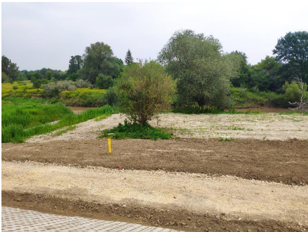
Fot. 19. Wał lewy, km ok. 5+200 – widok na uporządkowanie terenu po zakończonych pracach (2. dekada sierpnia 2023 r.).
