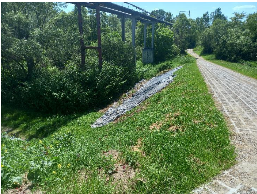
Fot. 18. Wał prawy, km ok. 0+500 – działania zagłuszania rozwoju roślinności inwazyjnej (rdestowców) poprzez okrywanie folią (3. dekada maja 2023 r.).
