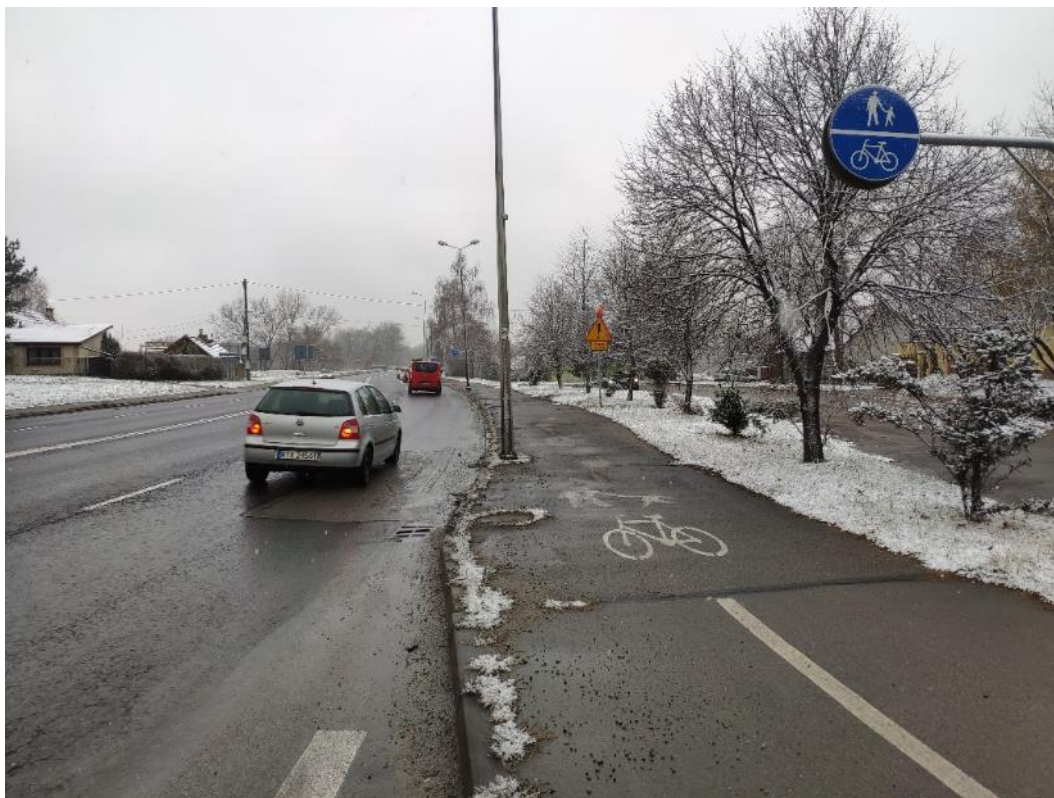
Fot. 9. Wał prawy, km ok. 3+200 – ul. Kwiatkowskiego w Tarnowie – przykład oznakowania wyjazdu z terenu budowy (1. dekada grudnia 2021 r.).
