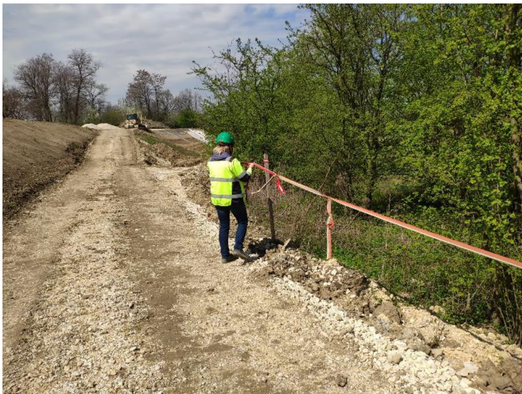
Fot. 17. Wał lewy, km ok. 5+200 – odbudowa uszkodzonych wygrodzeń zieleni (2. dekada kwietnia 2023 r.).
