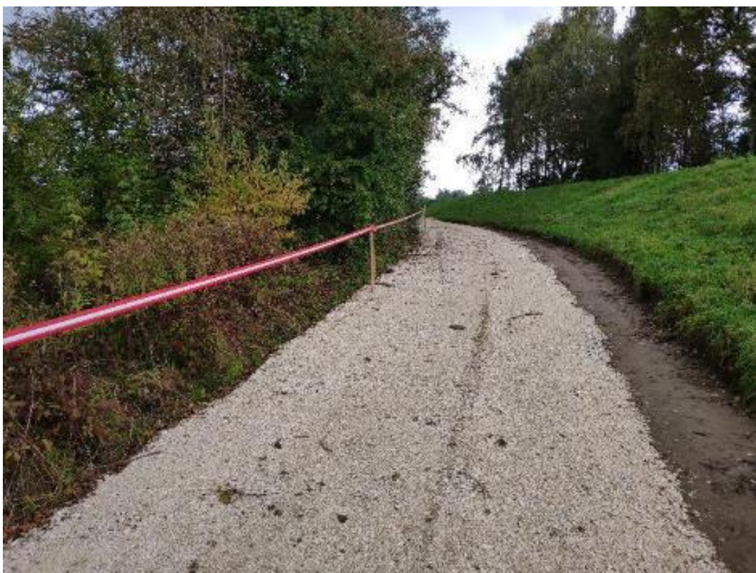
Fot. 8. Wał lewy, km ok. 5+300 – przykład wyгородzenia strefy zieleni pozostawionej poza wycinką wzdłuż drogi dojazdowej (1. dekada października 2021 r.).
