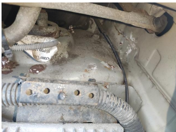
Korozja_nadkola L strona
