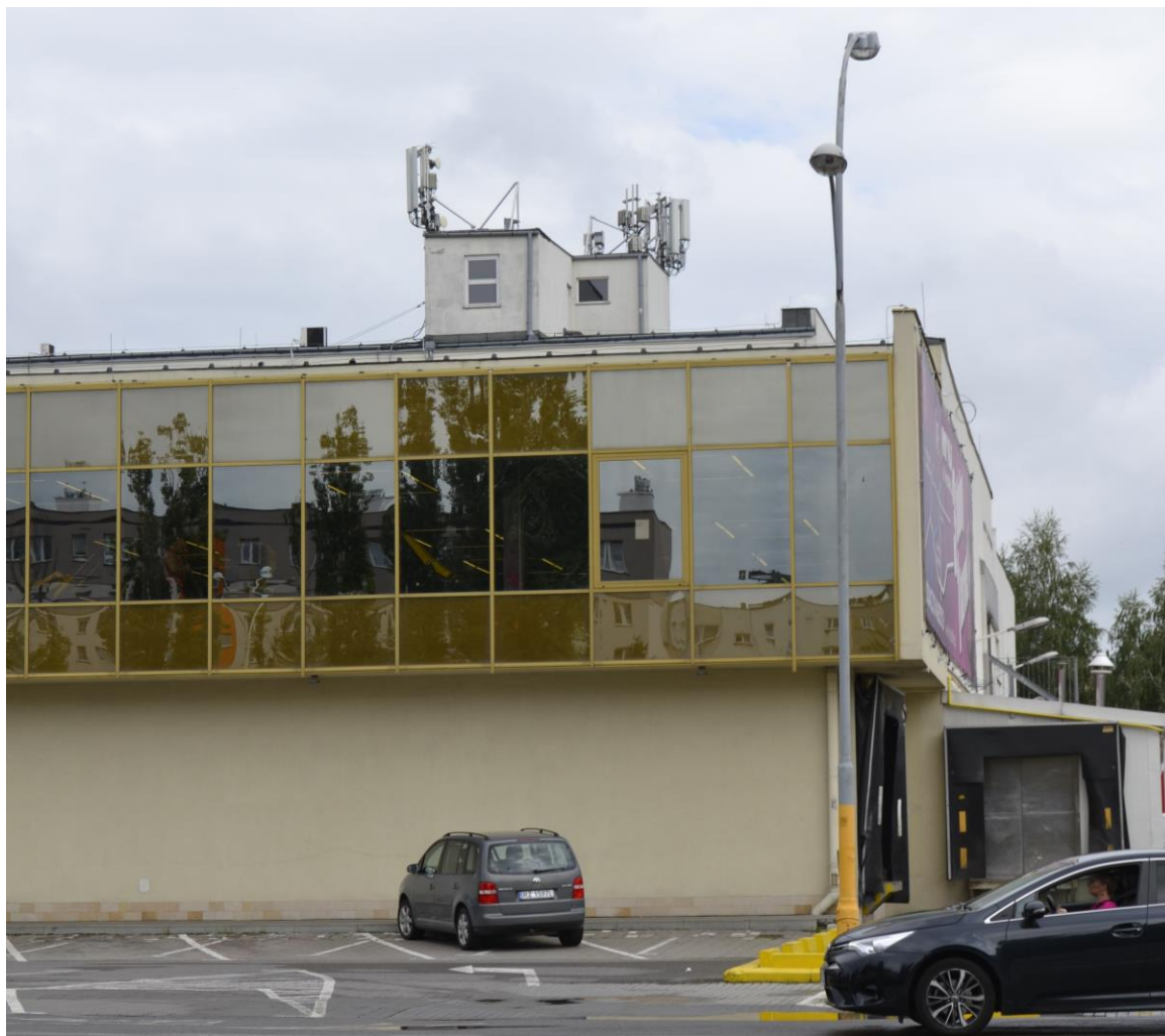
Fot. 1: Widok anten stacji bazowej ID: RZE1033A, zlokalizowanej przy ul. Lwowskiej 6 w Rzeszowie
