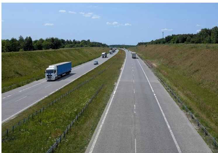
Fot. 6. Wierzchowisko (gm. Mykanów), RB2. Przebieg autostrady A1 w rejonie badawczym w kierunku Katowic.
