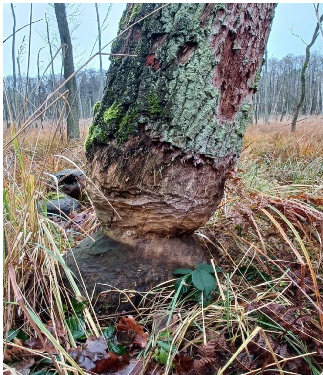
Rysunek 68. Ślady uszkodzeń od bobrów (Fot. Jerzy Czekirda)
