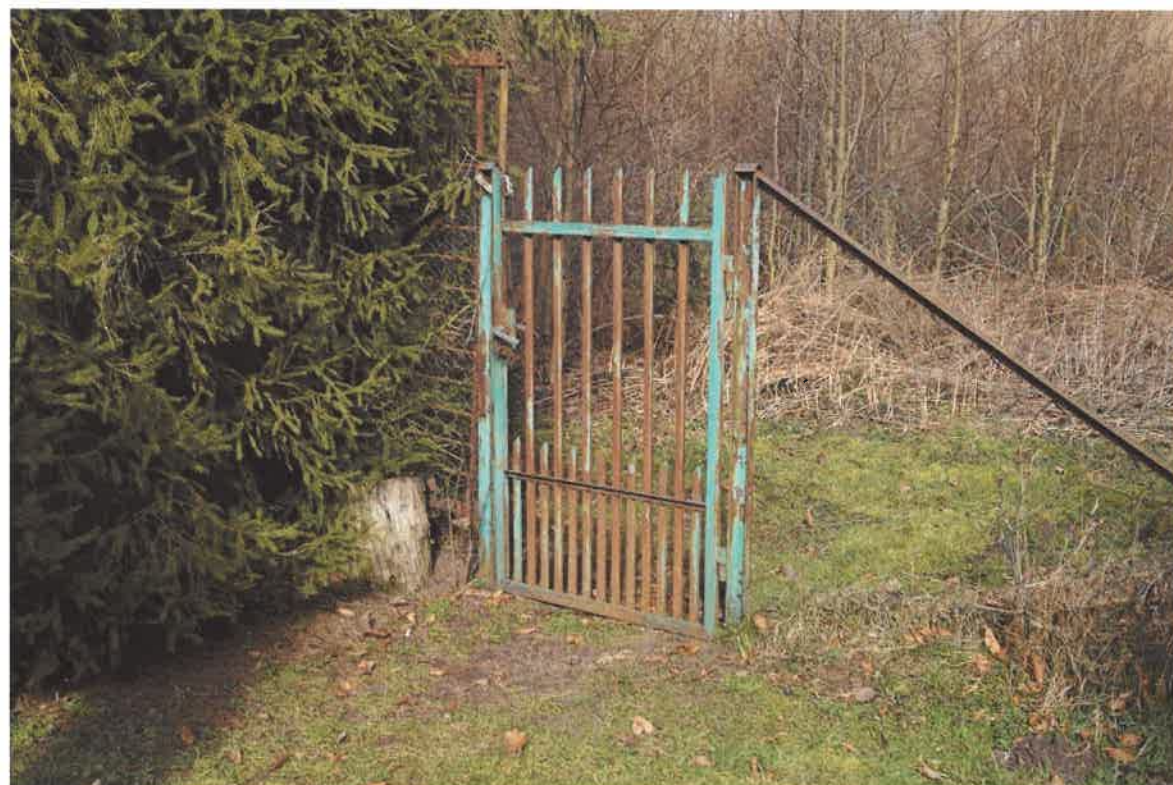
Furtka tylna do wymiany, ogrodzenie z siatki na słupkach stalowych do demontażu
