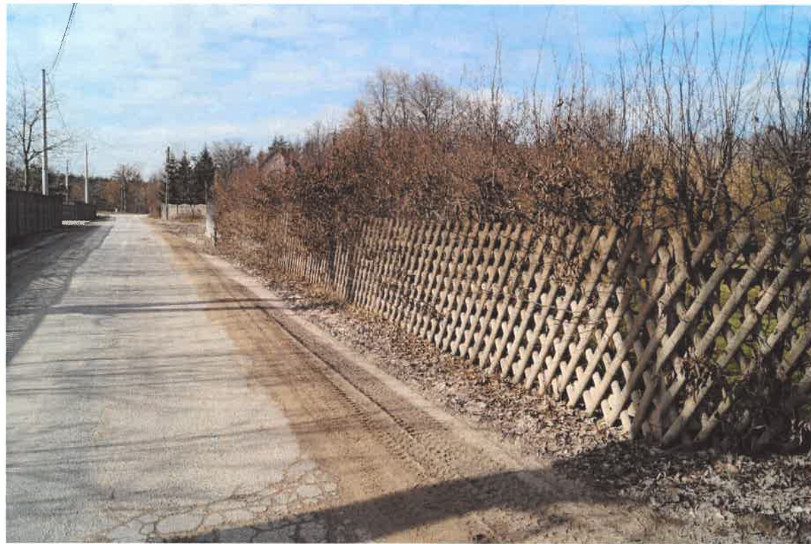
Ogrodzenie drewniane do demontażu
