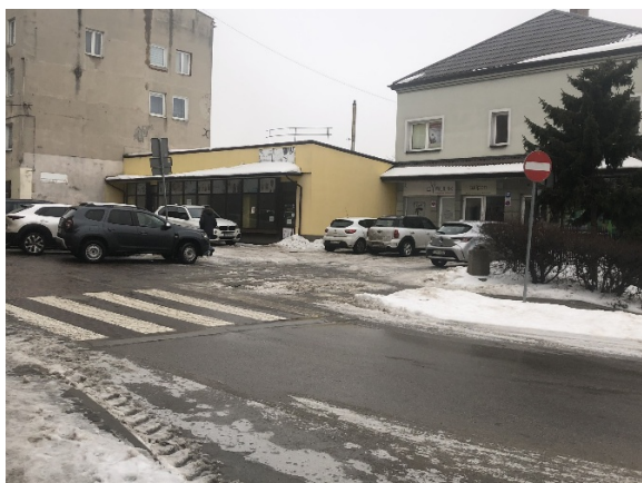
Zdjęcie nr 1 – brak znaku D-6 „przejście dla pieszych”
