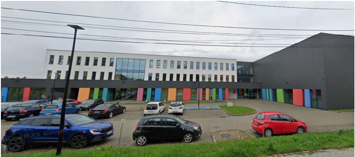
Zespół szkolno-przedszkolny wraz z salą gimnastyczną przy ul. Laryskiej 101 (źródło; Google Maps)
