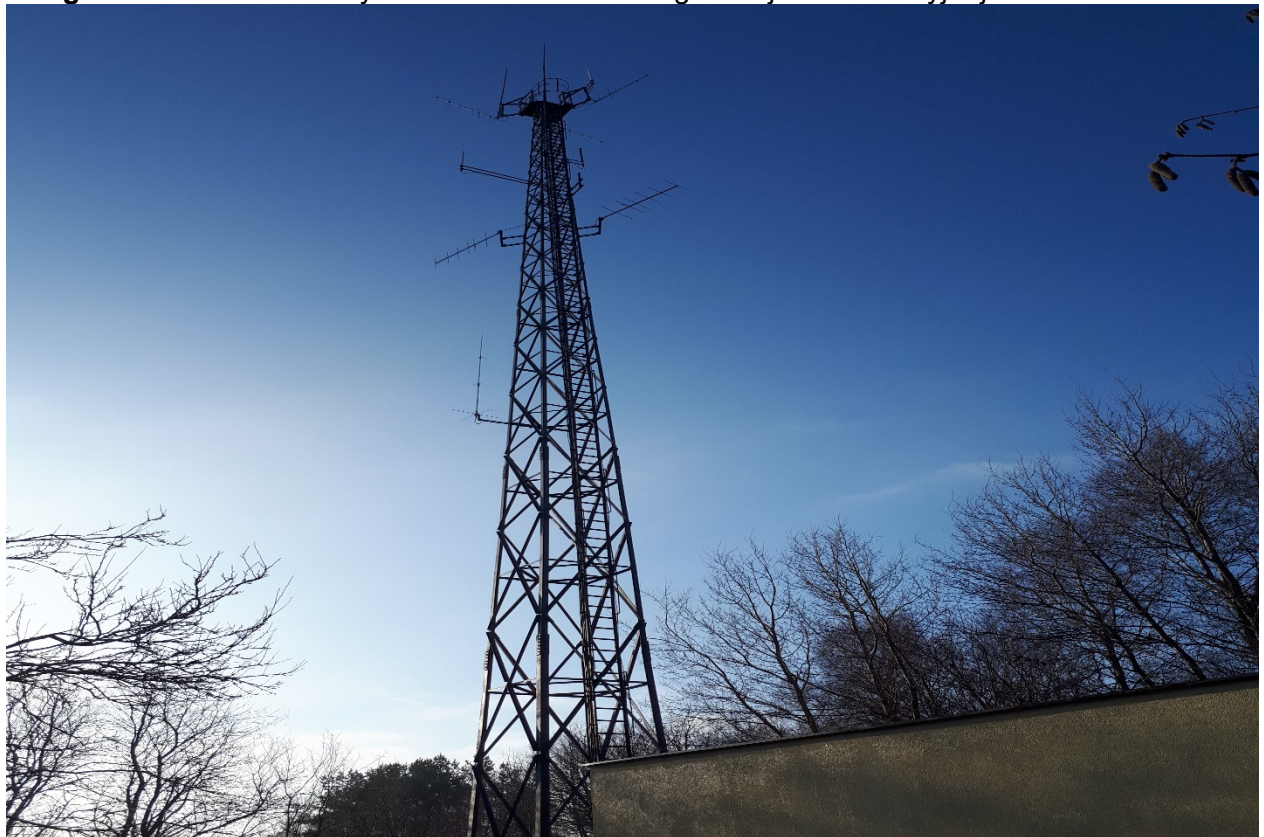
Fotografia nr 2. Widok masztu antenowego.
