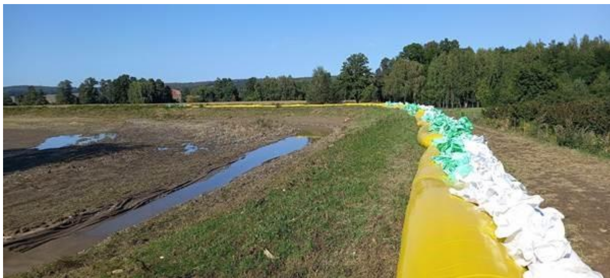
Rys. 12. Miejscowość Bliszczycze rz. Opawa zabezpieczony wał przeciwpowodziowy w km 66+300 – 70+000
