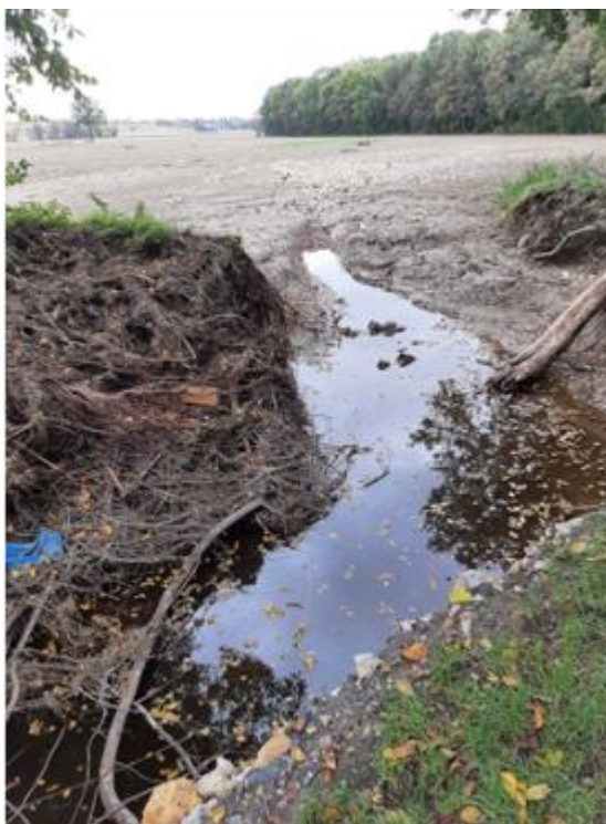
Rys. 18. Fotografia przedstawiająca szkody powstałe w wyniku powodzi z września 2024 r.
