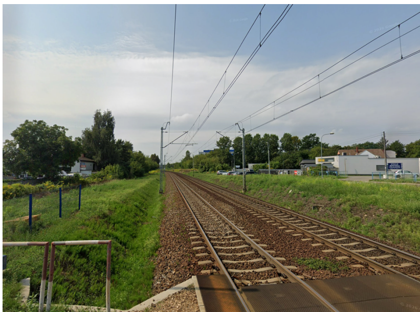
Fot. 2. Częstochowa, ul. Wały gen. Józefa Dwernickiego, RB1. Badany odcinek LK1, w kierunku Katowic (źródło Google Maps).
