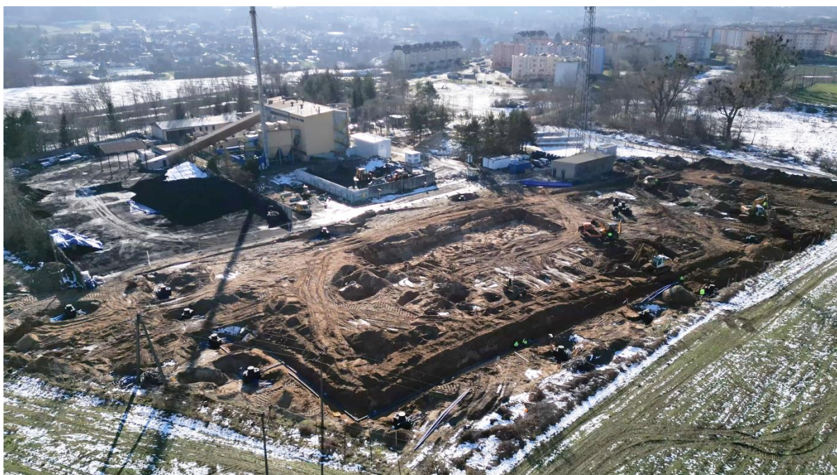
Rysunek 13. Widok na część połączeń poziomych oraz studni rozdzielaczowe gruntowego magazynu ciepła. Luty 2023.
