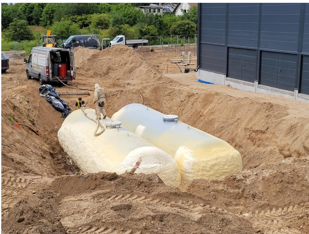
Rysunek 18. Bufor sieci ciepłowniczej - magazyn krótkoterminowy – przed zasypaniem.
