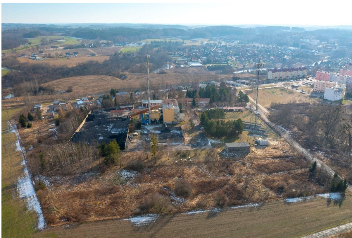
Rysunek 9. Widok na teren inwestycji przed rozpoczęciem prac. Marzec 2022.
