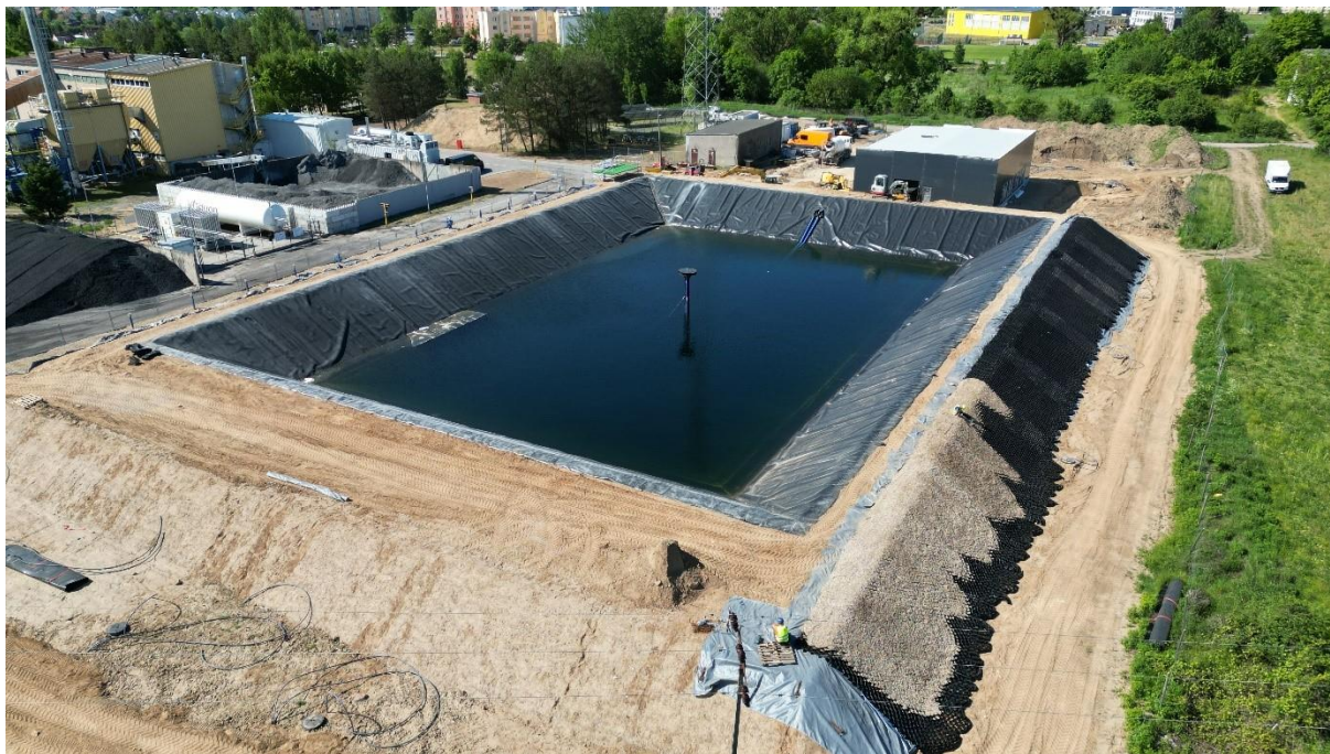
Rysunek 14. Wykańczanie i zabezpieczanie wałów basenu. Napełnianie wodą z sieci wodociągowej. Maj 2023.
