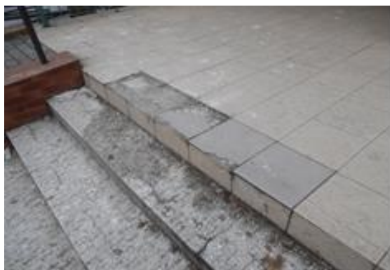
Rys. 28 Niewłaściwy stan techniczny schodów na korytarzach poziomu piwnicznego
