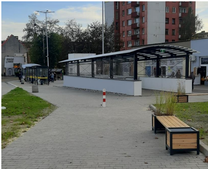
Zdjęcie: Przejście podziemne łączące ul. Oświęcimską z ul. Powstańców oraz peronami dworca PKP
