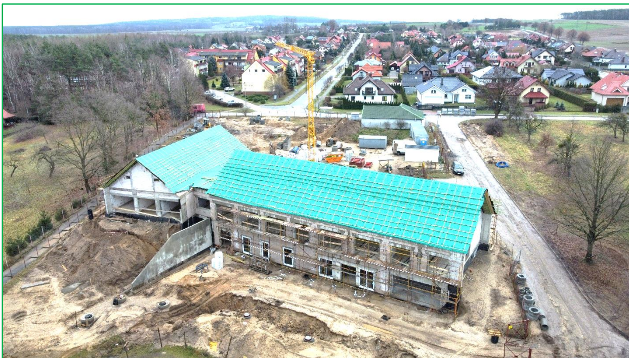
Budowa nowej siedziby Nadleśnictwa Kaczory oddz. 566g (grudzień 2023 r.)
