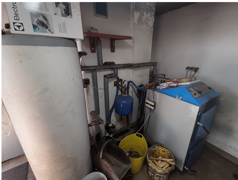
Zdjęcie nr 2 - Widok kotłowni Leszno Górne Kolonia 7
