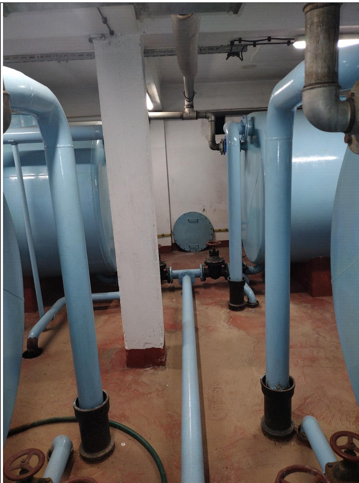
Fot. B_15 Instalacja Hydroforni p.poz.
