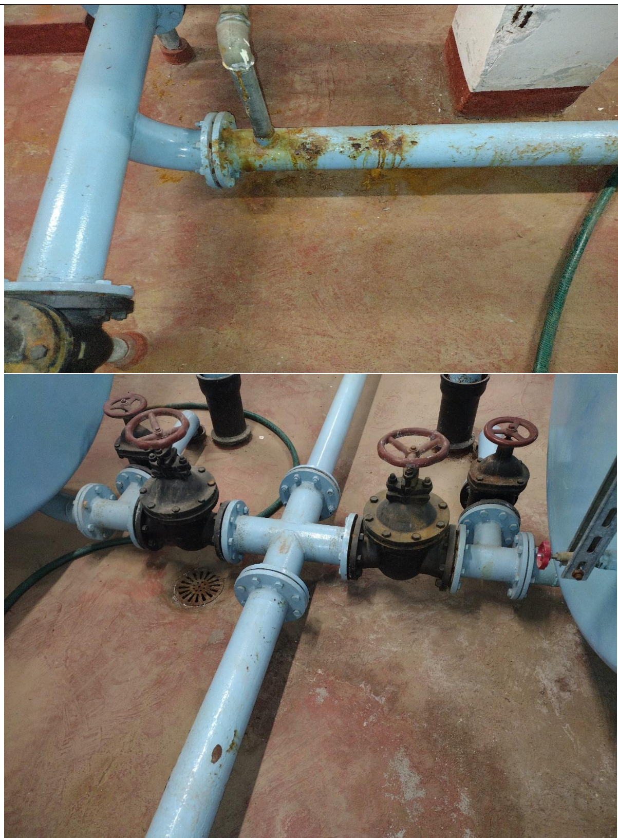
Fot. B_13 i B_14 Instalacja – rurociągi plus zawory ( hydrofornia p.poż.)
