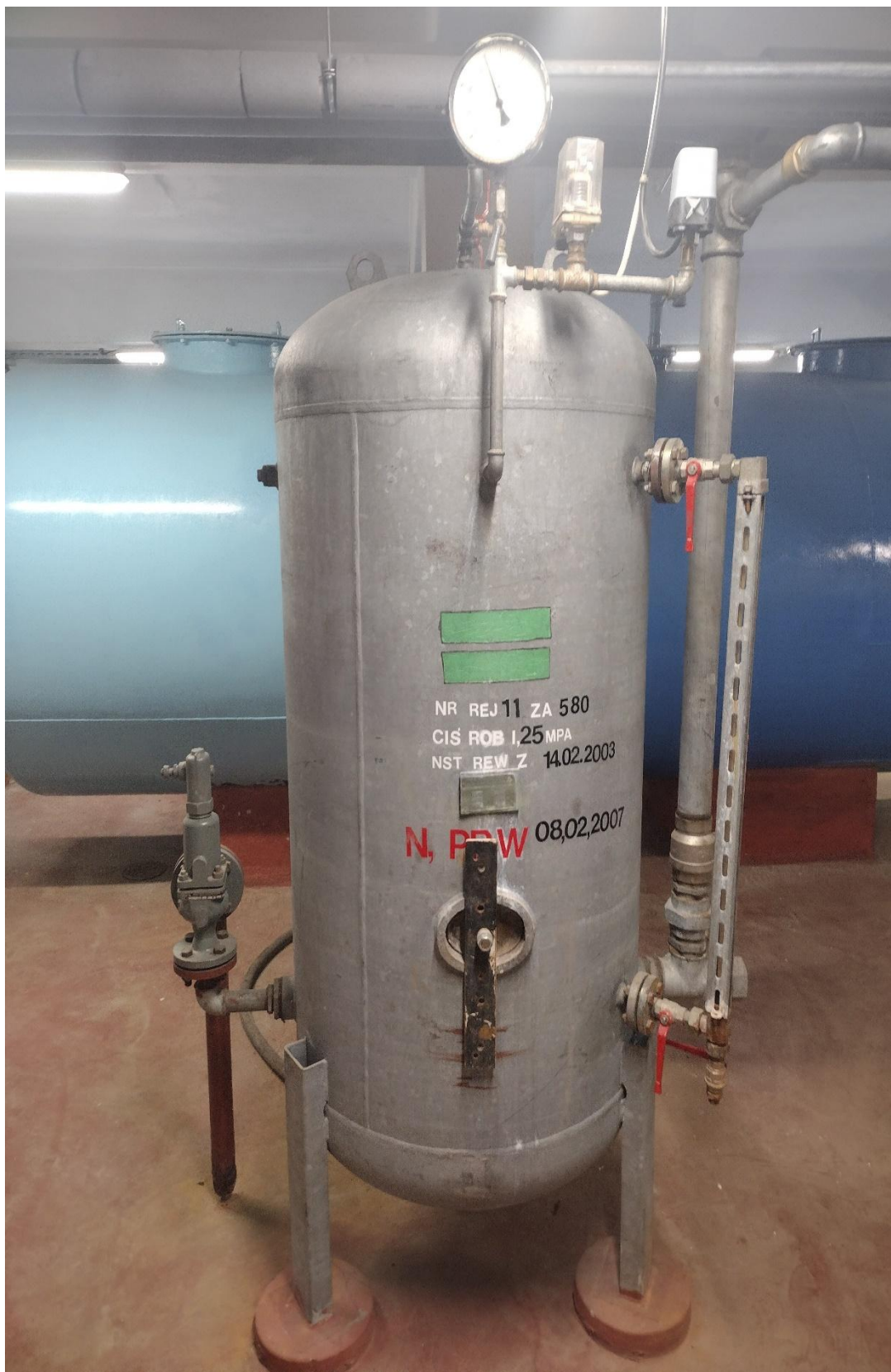
Fot. B_4. Zbiornik ciśnieniowy 800 l. (zestaw hydroforowy p.poż.)
