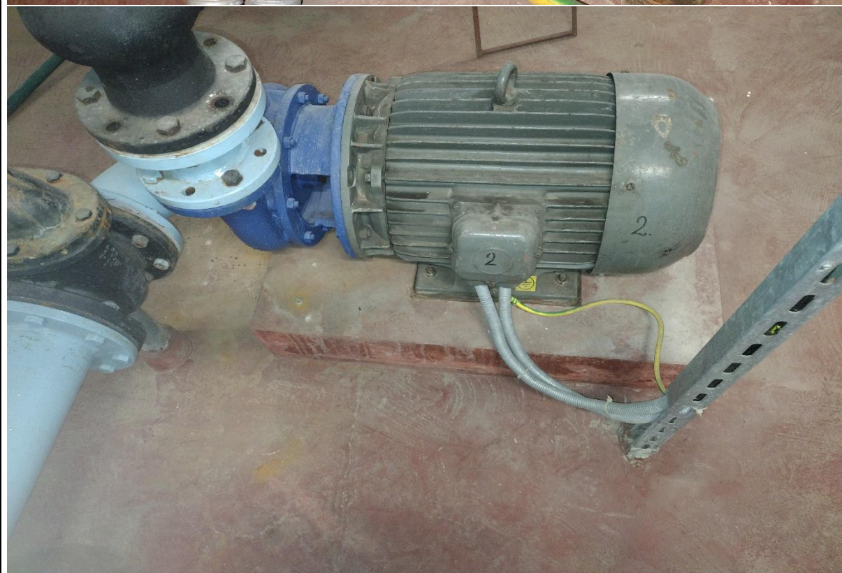
Fot. B_11 i B_12 Pompa SL-e-180.4.2 ( instalacja p.poż.)
