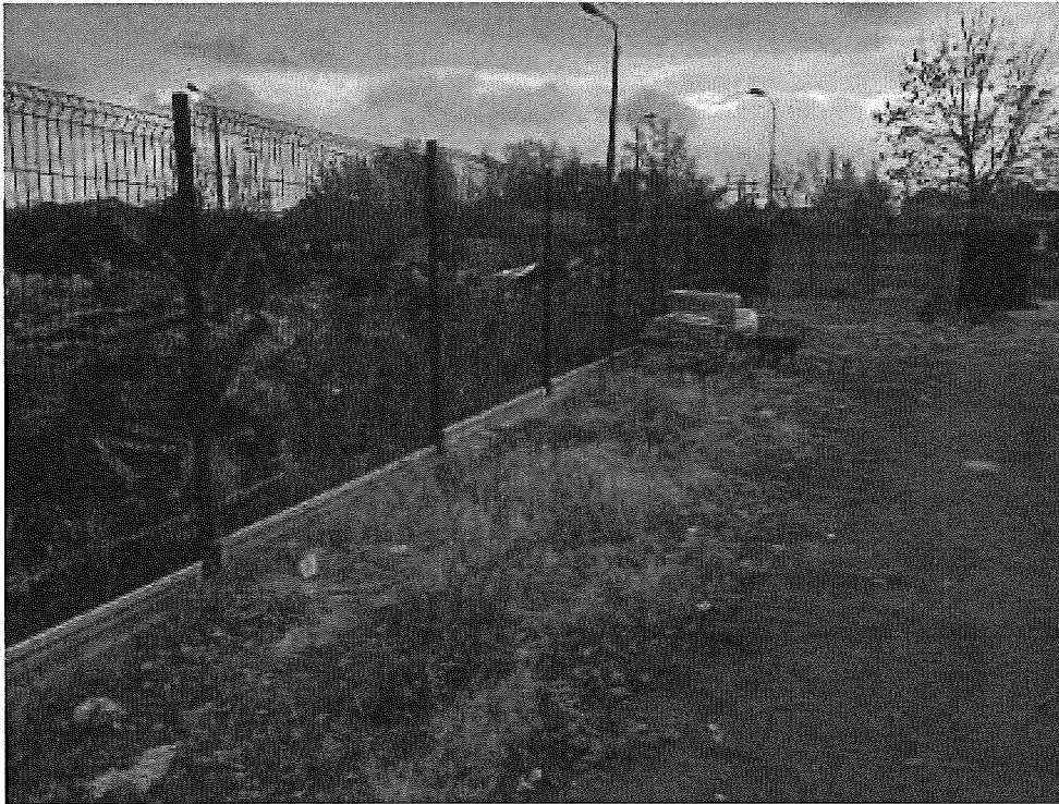
fot. Wykonane ogrodzenie.
