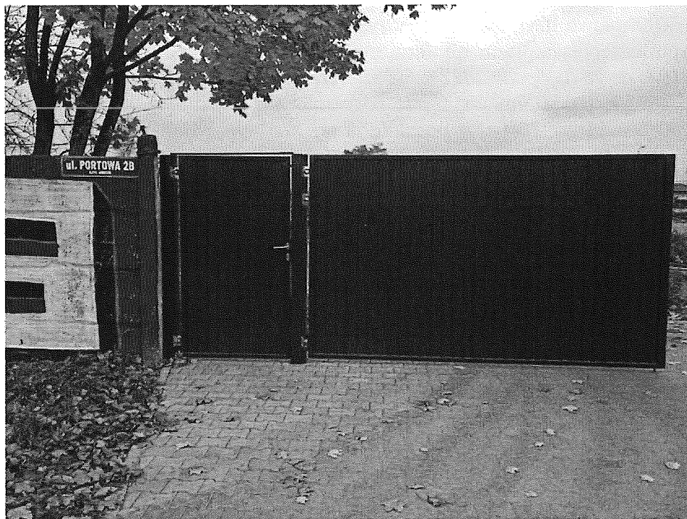
fot. Brama wjazdowa.
