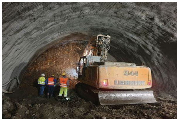
► Rys. 10. Prace drążeniowe prowadzone w tunelu z wykorzystaniem koparki gąsienicowej
