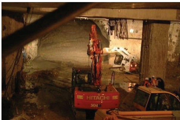
► Rys. 11. Początkowa faza wypływu gruntu po przebicciu stropu wyrobiska
