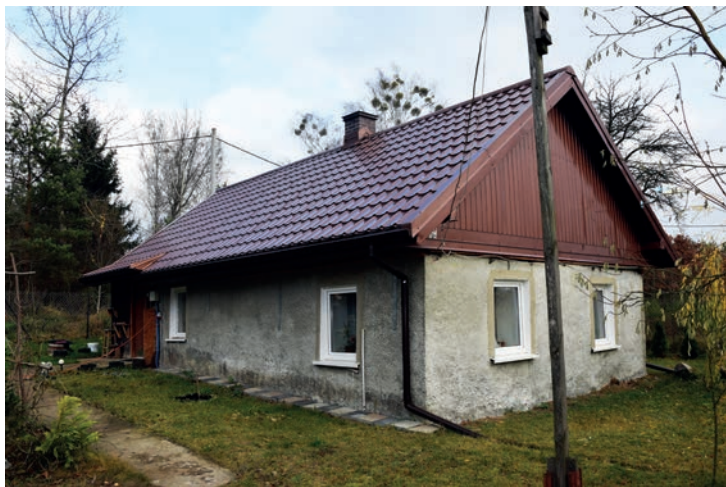
2. Płoskie nr 19 – widok na budynek z zewnątrz.
