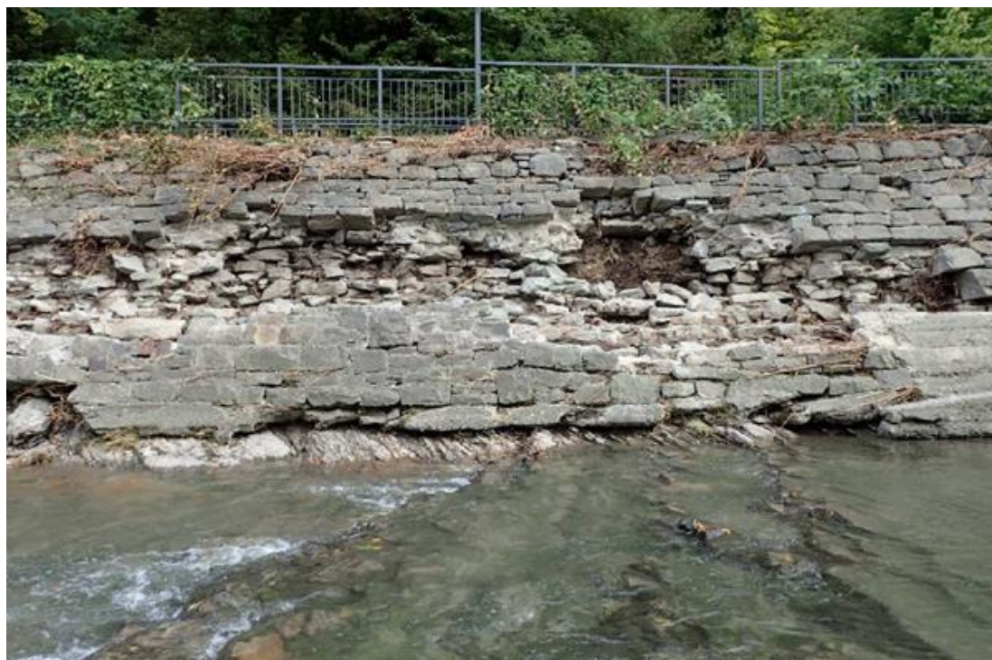
Rys. 14. Miejscowość Cieszyn rz. Olza uszkodzony mur oporowym
