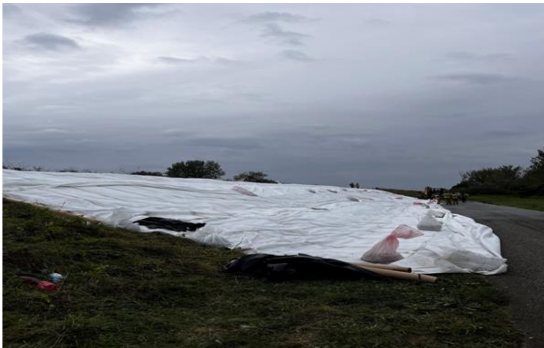
Rys. 13. Miejscowość Uchylsko i Olza rz. Olza zabezpieczony wał przeciwpowodziowy
