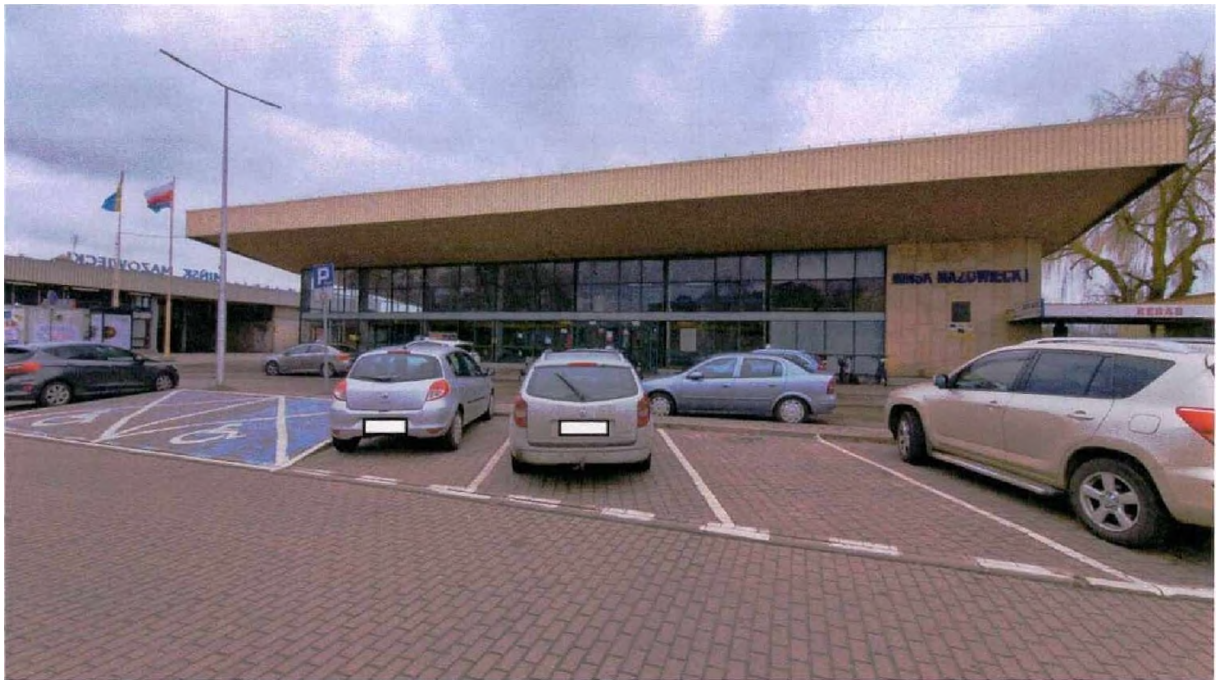
Przód stacji PKP w Mińsku Mazowieckim. (zdjęcie własne wykonane w dniu 1 lutego 2025 r.)
