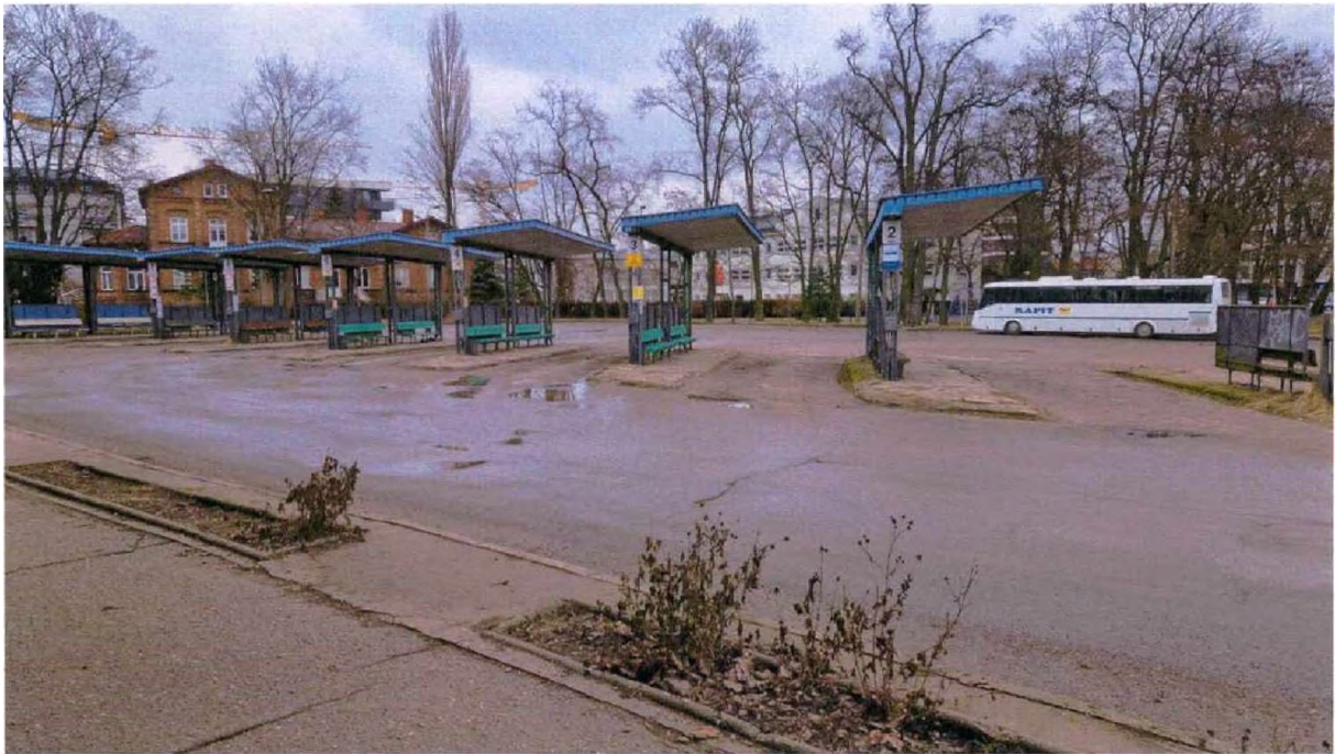
Zaniedbana część autobusowa przy stacji. (zdjęcie własne wykonane w dniu 1 lutego 2025 r.)
