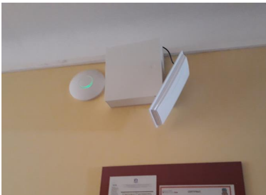
Fot. 1a, b: Widoki punktów dostępowych model UniFi UAP
