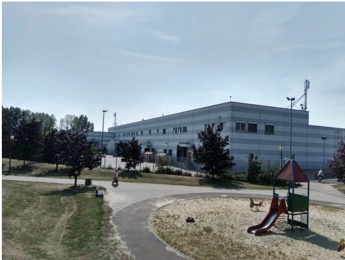
Fot. 1: Widok anten stacji bazowej ID OPO1017_A, zlokalizowanej przy ul. Sosnkowskiego 16 w Opolu
