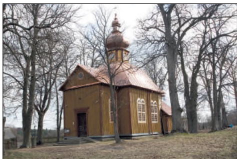
29. Stary Bubel, kościół filialny, po zakończeniu prac przy kopule i dachu, fot. J. Maraśkiewicz
