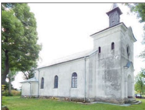
33. Uhrusk, cerkiew przed rozpoczęciem prac remontowych, fot. Delegatura WUOZ, 2016
