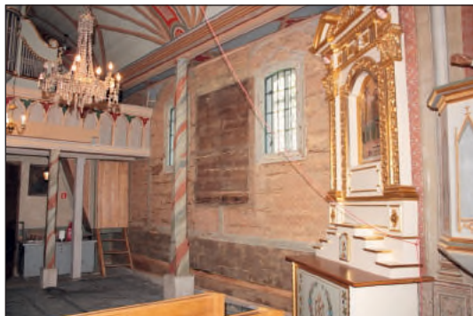
3. Bukowina – kościół filialny – malowidła ściany pn. w trakcie prac, fot. A. Guzik 2018 r.
