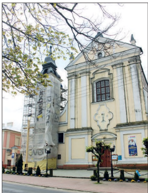
6. Janów Podlaski, kościół parafialny, fasada w trakcie prac, fot. J. Maraśkiewicz, 2018
