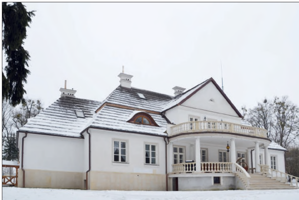
18. Zaburze, dwór, przywrócone pokrycie gontem
