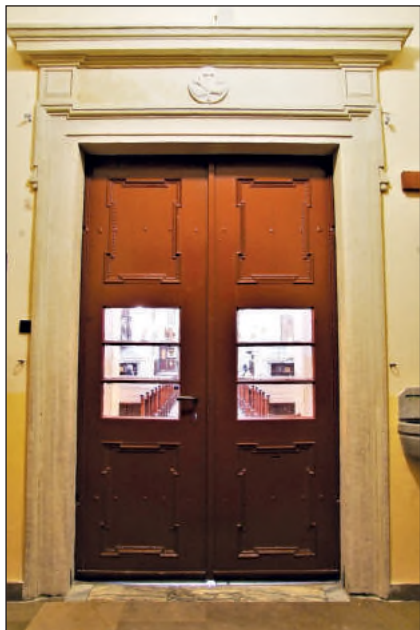
1. Biała Podl. – kościół kapucynów – portal po pracach, fot. A. Andryszczak 2018 r.
