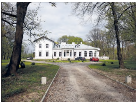
17. Kulik, dwór po wykonaniu prac remontowych, fot. M. Pędzińska, 2019
