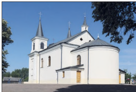
4. Buśno, kościół po zakończeniu prac, fot. P. Wira, 2019
