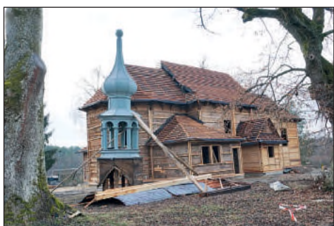
18. Łosiniec, kościół w trakcie robót, fot. M. Fornal
