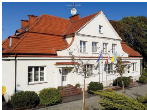
12. Chełm, budynek w zespole Dyrekcja, dach pokryty dachówką
