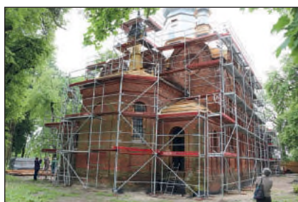
12. Dubienka, cerkiew w trakcie prac remontowych, fot. M. Pędzińska, 2018
