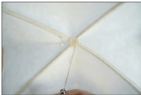
1. Kraśnik, kościół pw. Wniebowzięcia NMP – sklepienie zakrystii po konserwacji, fot. B. Stolarz, 2018
