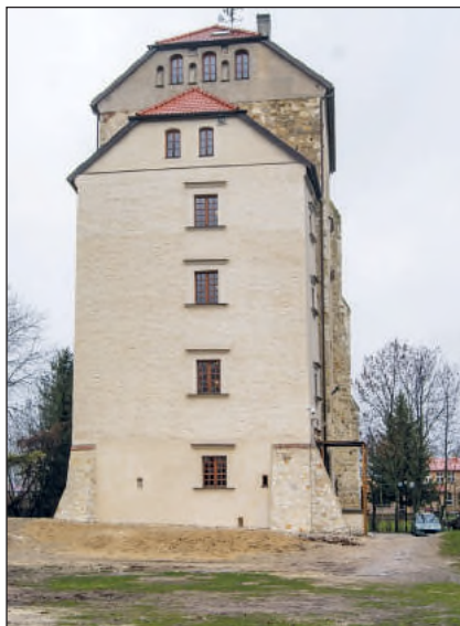
38. Wojciechów, wieża ariańska, stan po remoncie elewacji pld., fot. M. Kurczewicz, 2018
