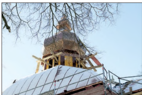
30. Stary Bubel, kościół filialny w trakcie remontu, fot. J. Maraśkiewicz
