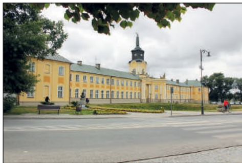
23. Radzyń Podlaski, pałac Potockich, skrzydło zach. po remoncie, fot. J. Maraśkiewicz
