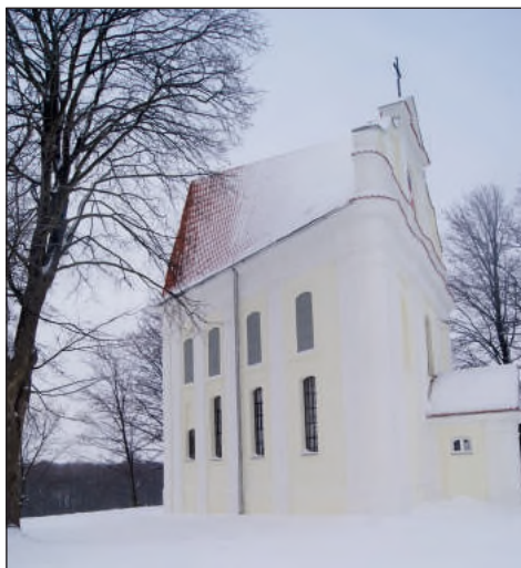
15. Stróża, kaplica, przywrócona forma i pokrycie dachu
