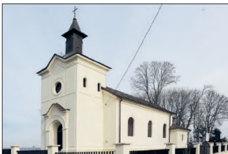
32. Uhrusk, cerkiew w trakcie prowadzenia prac remontowych, fot. M. Pędzińska, 2019
