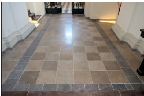
3. Lublin bazylika oo. dominikanów, odtworzona posadzka w kaplicy Ossolińskich, fot. M. Filip, 2018
