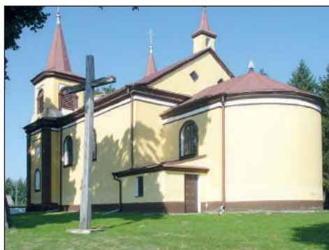
5. Buśno, kościół, przed rozpoczęciem prac, fot. Delegatura w Chełmie, 2012
