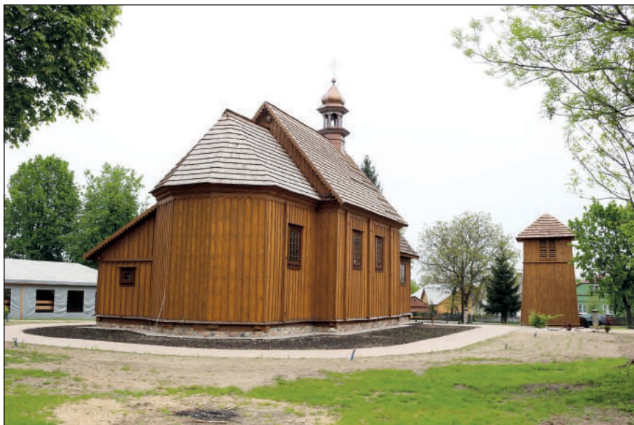
41. Żmudź, kościół, po zakończeniu prac remontowych, fot. P. Wira, 2018
