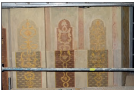
11. Kraśnik, kaplica MB NP – fragm. dekoracji ścian kaplicy w trakcie prac, fot. A. Trocha, 2018.
