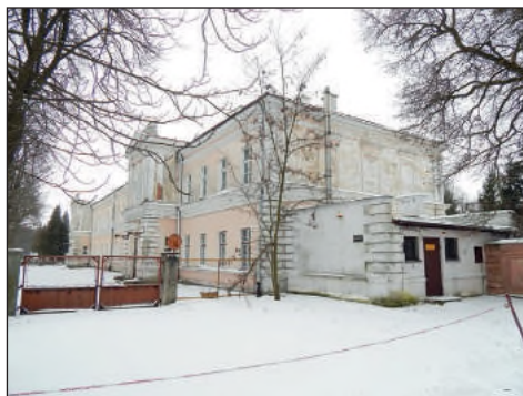
6. Chełm, budynek administracji i sztabu d. szpitala wojskowego, widok ogólny przed pracami, fot. M. Wilk
