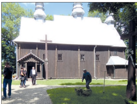
13. Hanna, kościół przed rozpoczęciem prac remontowych, fot. M. Pędzińska, 2014
