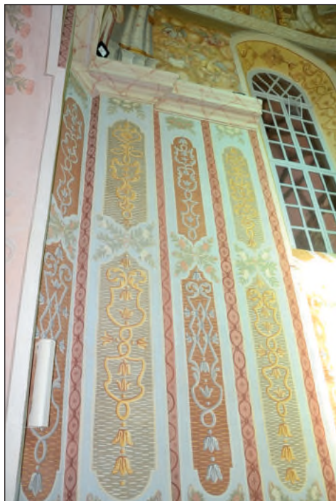
12. Kraśnik, kaplica MB NP – fragm. dekoracji ścian kaplicy po pracach, fot. K. Tur-Marciszek, 2019.
