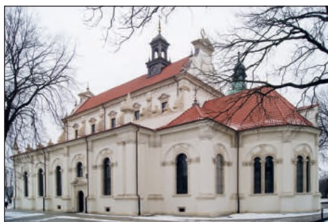
14. Zamość, katedra, przywrócona forma i pokrycie dachu
