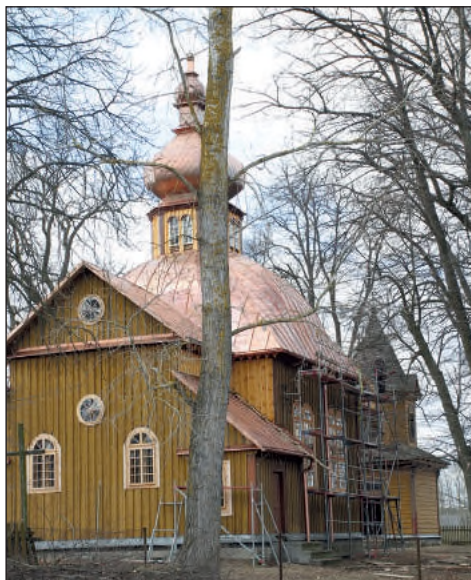
28. Stary Bubel, kościół filialny, w trakcie remontu, fot. J. Maraśkiewicz
