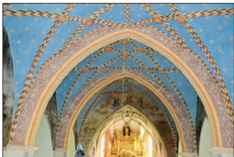
14. Kraśnik, kościół pw. Wniebowzięcia NMP – sklepienie przęseł nawy gł. po konserwacji, fot. B. Stolarz 2018
