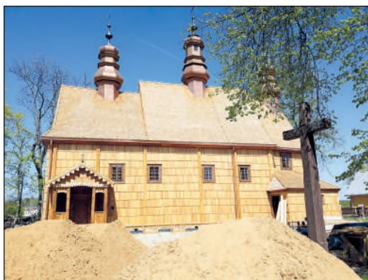
14. Hanna, kościół w trakcie prowadzenia prac remontowych, fot. M. Pędzińska, 2019
