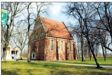
8. Kodeń, kościół pw. Ducha Św., dach pokryty dachówką
