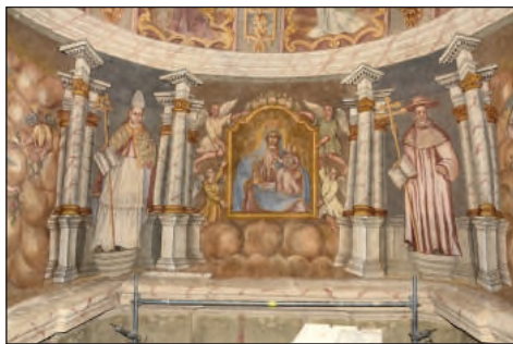
10. Kraśnik, kaplica MB NP – fragm. dekoracji ściennej tamburu kopuły po pracach, fot. A. Trocha, 2017.
