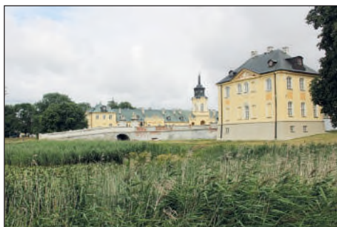
24. Radzyń Podlaski, pałac Potockich, skrzydło zach. po remoncie, fot. J. Maraśkiewicz
