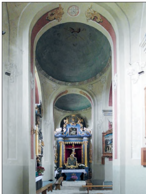
42. Tarnogród – kościół par. – polichromia nawy pn. przed pracami, fot. M. Filip 2018 r.
