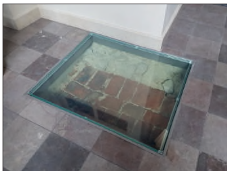
7. Lublin bazylika oo. dominikanów, nowa posadzka w kaplicy Szaniawskich z zachowanym fragm. ceglanej nawierzchni, fot. M. Filip, 2018
