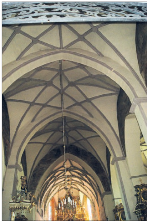
12. Kraśnik, kościół pw. Wniebowzięcia NMP – sklepienie nawy gł. przed konserwacją fot. B. Stolarz 2014
