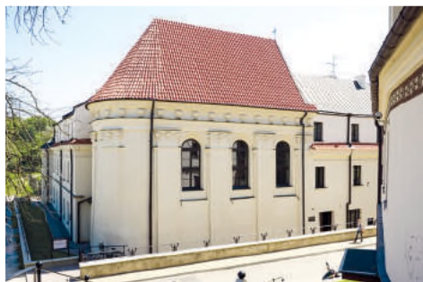
7. Lublin, kościół szpitalny św. Wojciecha, dach pokryty dachówką
