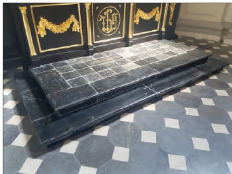
9. Lublin bazylika oo. dominikanów, posadzka w kaplicy Firlejów z odtworzonymi stopniami ołtarza, fot. M. Filip, 2018
