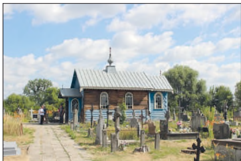
31. Terespol, prawosławna kaplica cmentarna, w trakcie remontu, fot. J. Maraskiewicz
