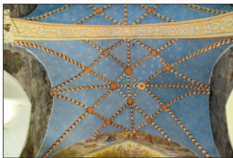
13. Kraśnik, kościół pw. Wniebowzięcia NMP – sklepienie przęsła nawy głównej po konserwacji, fot. B. Stolarz 2018
