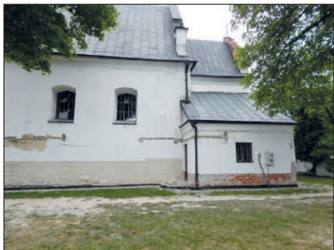
16. Klesztów, kościół w trakcie prowadzenia prac, fot. M. Pędzińska, 2016
