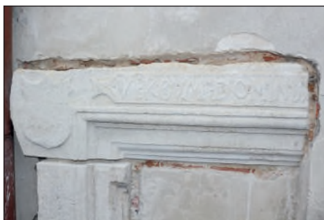
27. Krasnystaw – d. pałac biskupi – portal w trakcie prac, fot. P. Wira 2018 r.
