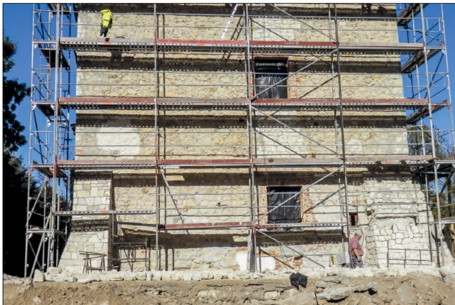
40. Wojciechów, wieża ariańska, stan w trakcie remontu elewacji pld., fot. M. Kurczewicz, 2018
