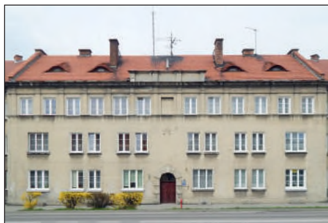
13. Chełm, budynek w zespole Dyrekcja, dach pokryty dachówką
