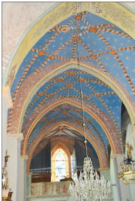
16. Kraśnik, kościół pw. Wniebowzięcia NMP – sklepienie nawy gł. po konserwacji, fot. B. Stolarz 2018 r.
