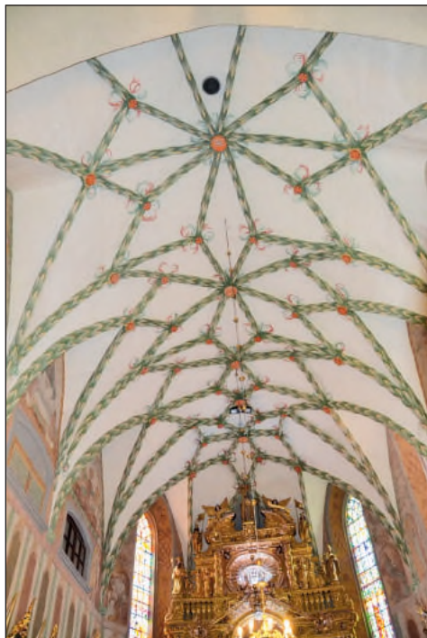
5. Kraśnik, kościół pw. Wniebowzięcia NMP – sklepienie prezbiterium po konserwacji, fot. B. Stolarz, 2018
