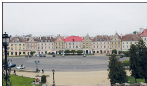
17. Lublin, Plac Zamkowy, stan obecny, dachy kryte blachą
