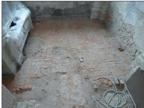
5. Lublin bazylika oo. dominikanów, odkryta posadzka ceglana w kaplicy Szaniawskich, fot. M. Filip, 2018
