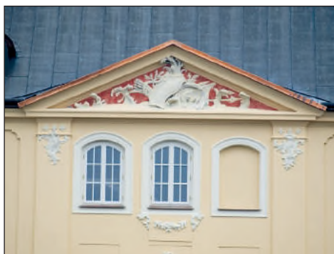
50. Radzyń Podl. – zespół pałacowy – tympanon po pracach, fot. Z. Kamińska 2018 r.
