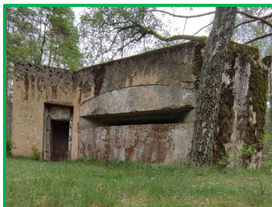
Fot.55. Bunkier na ścieżce rowerowo – pieszej „Po bunkrach poligonu Gross Born” (Fot. N-ctwo Czarnobór)
